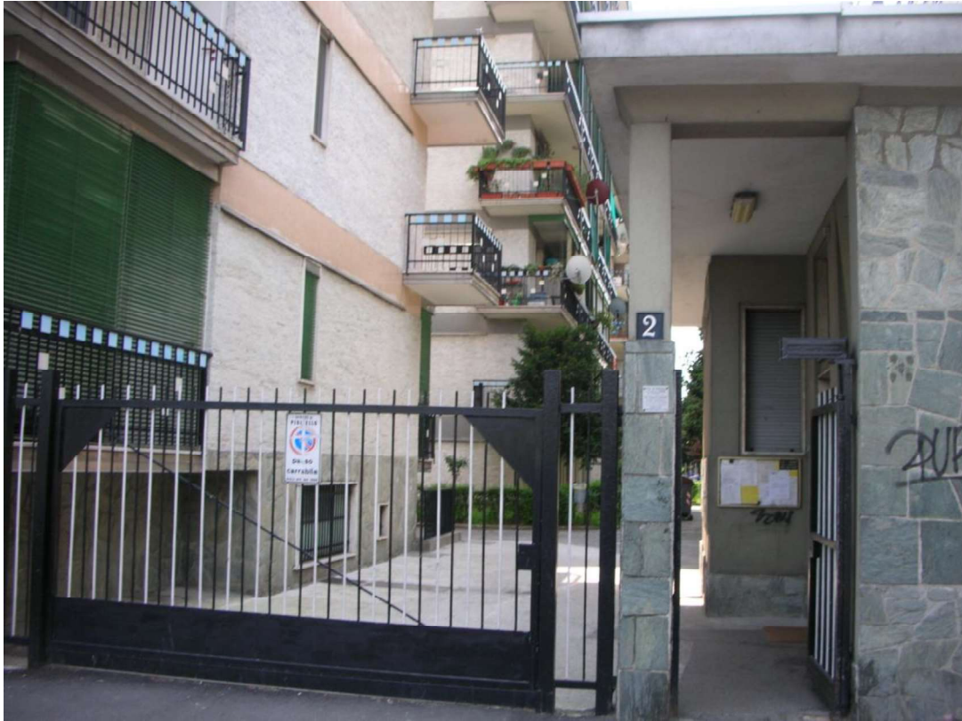
Accesso Complesso edilizio – Portineria – Via Puccini
