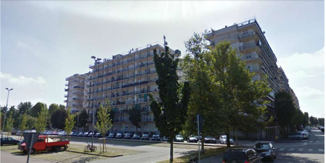
Vista Fabbricato - via Puccini
