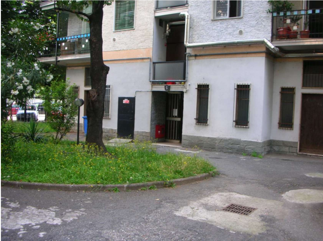
Ingresso edificio – Corpo C
