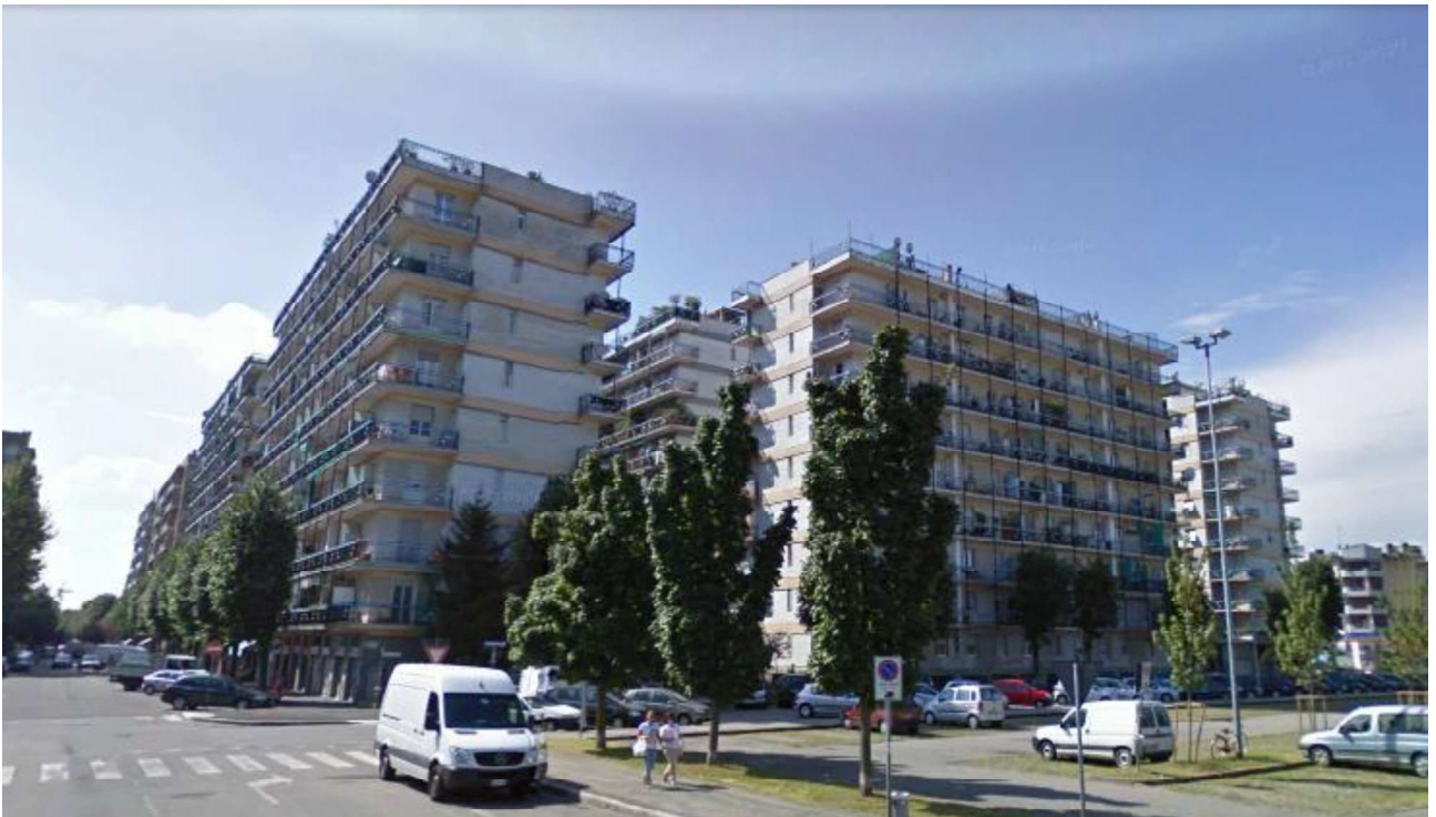
Vista Fabbricato da incrocio via Puccini – via Mozart (lato sinistro)
