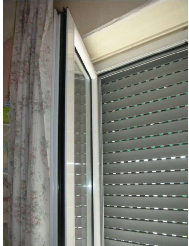
Serramento in alluminio anodizzato e vetro camera
