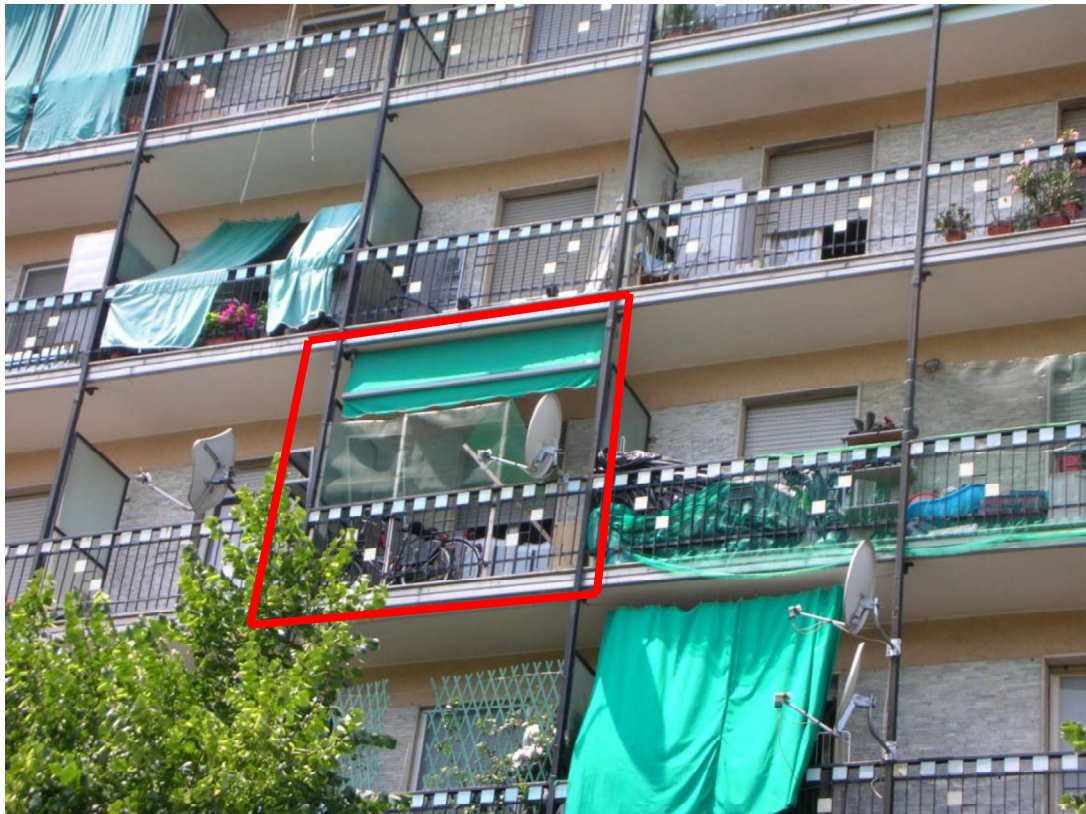
Facciata appartamento – lato via Mozart
