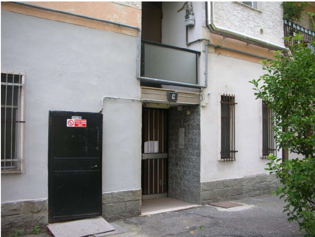
Ingresso edificio – Corpo C
