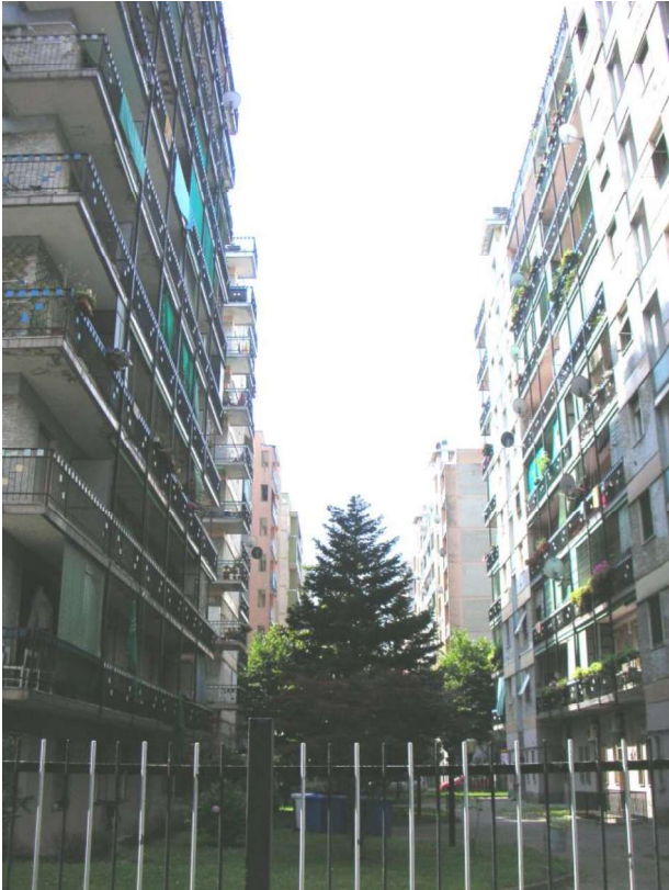
Fabbricato adiacente - Vista da Corpo D
