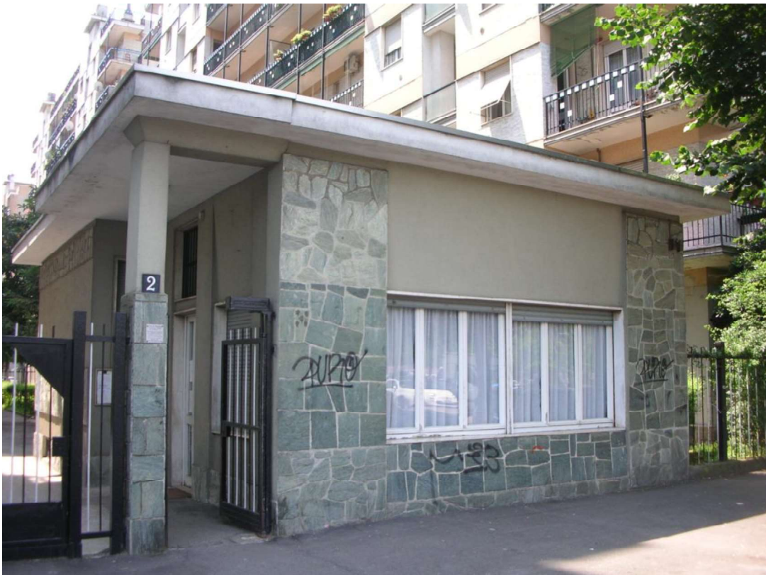
Accesso Complesso edilizio – Portineria – Via Puccini
