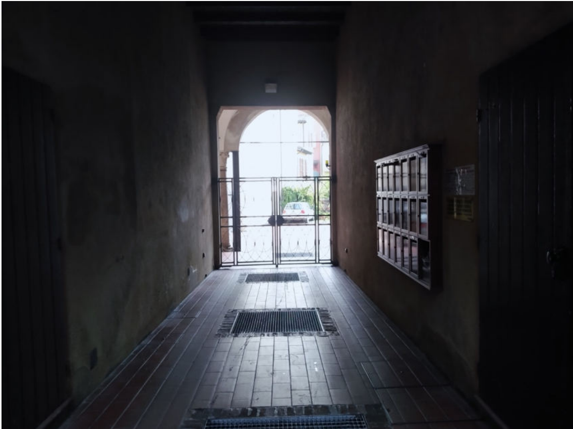
Fot.4 – Vista dell' ingresso carrabile del "Palazzo Caporali" dalla Via Verzaglia.
