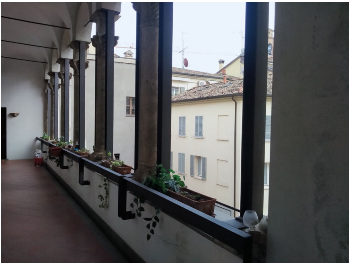
Fot.9 – Vista del loggiato piano primo lato corte.
