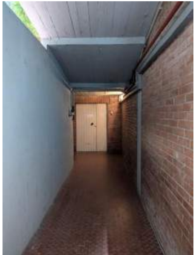
Foto n. 21 Corridoio piano seminterrato ingresso cantine
