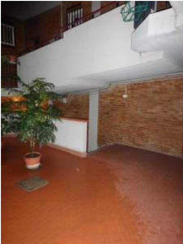
Foto n. 20 Rampa di ingresso al seminterrato
