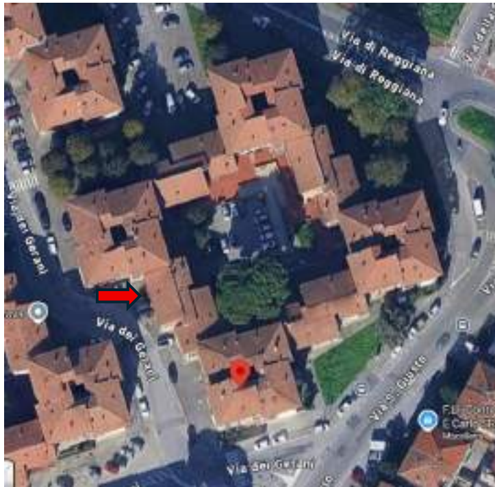
Fig. 3 Corte “L”, posizionata fra via San Giusto e via dei Gerani, con individuazione torre “70”, lato sud ed ingresso carrabile dalla via dei Gerani 2-16.
