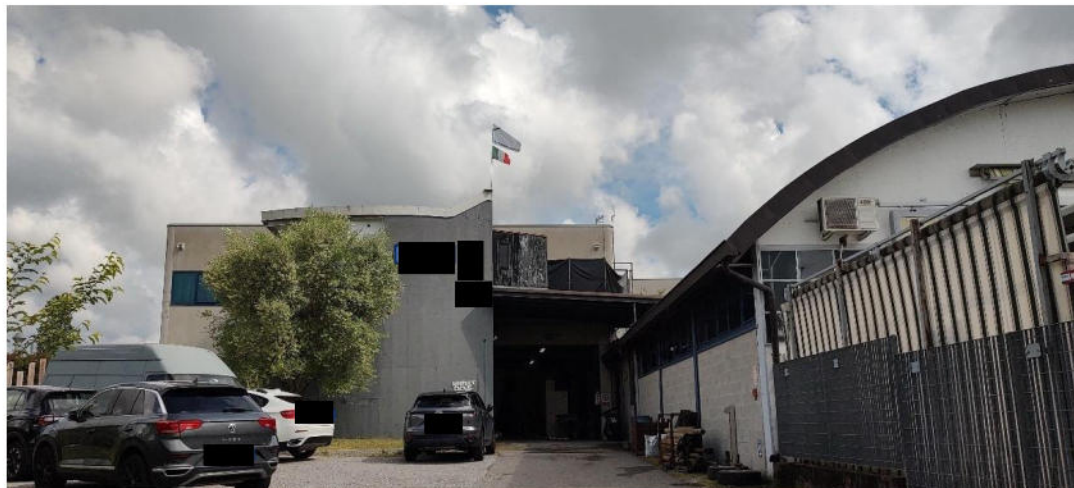
Veduta dell'ingresso dal cortile comune in lato sud
