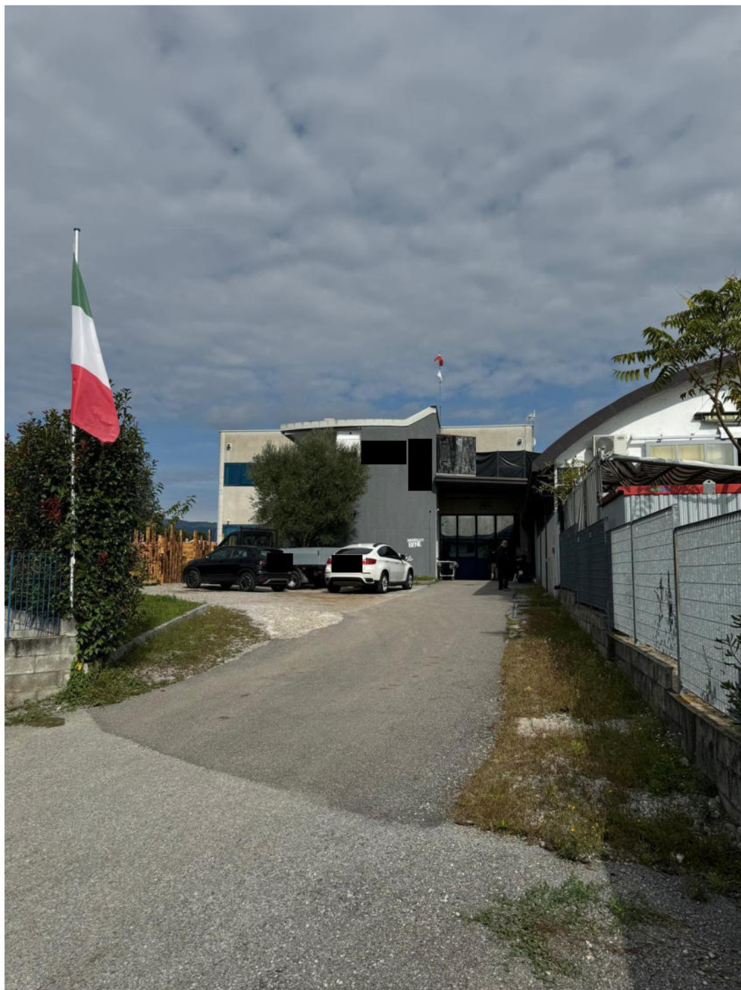
Veduta dal cancello di ingresso posto sulla via Sant'Isidoro
