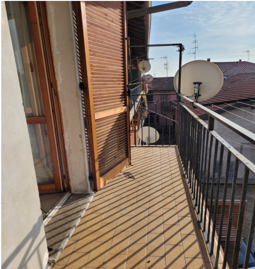
Balcone al piano secondo
