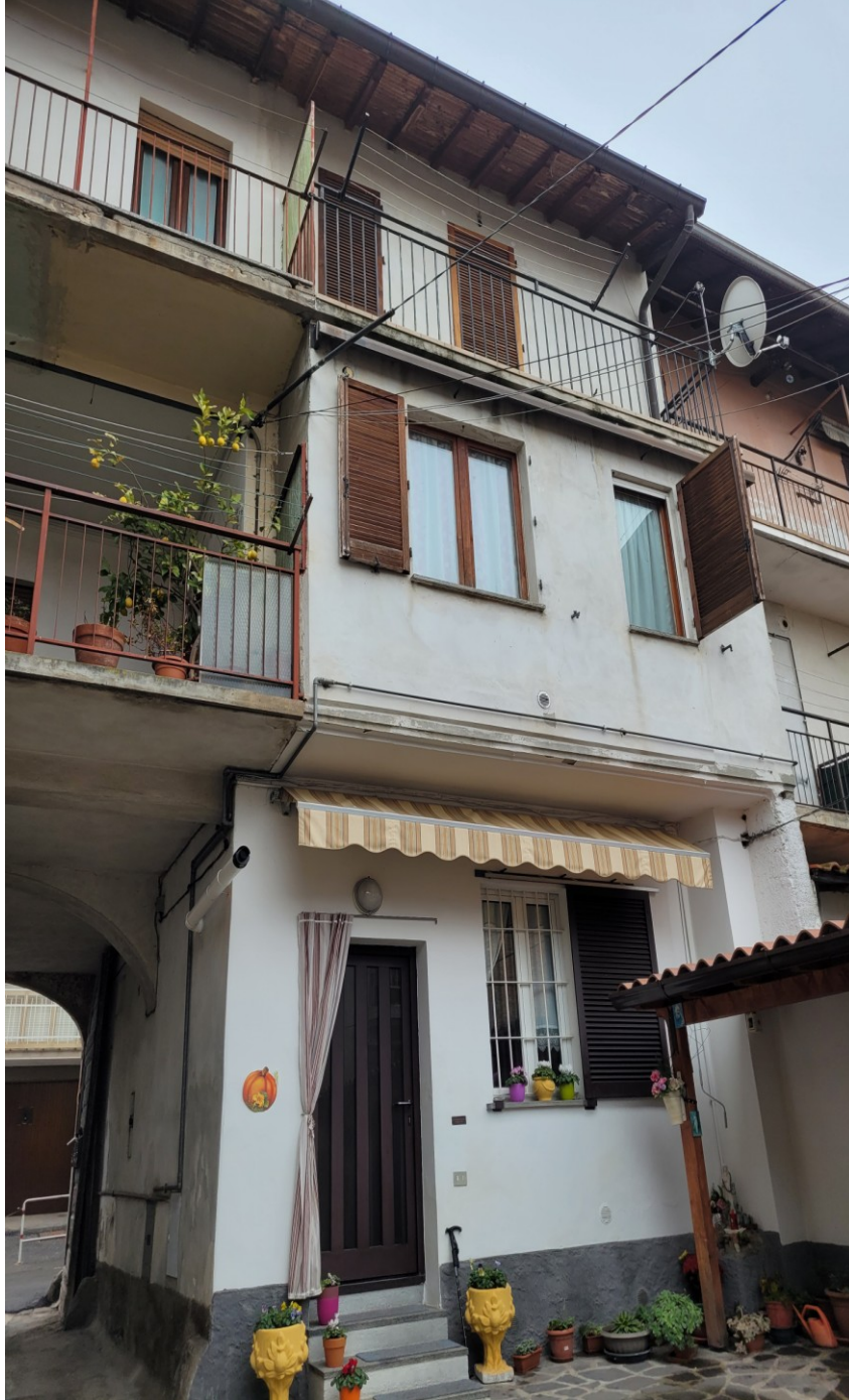
Facciata sul cortile (piani primo e secondo)
