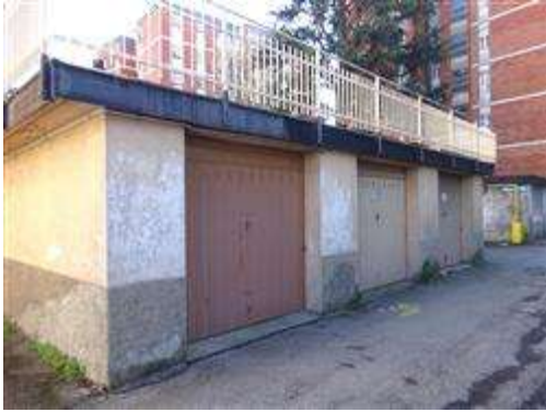
Corpo esterno delle autorimesse
