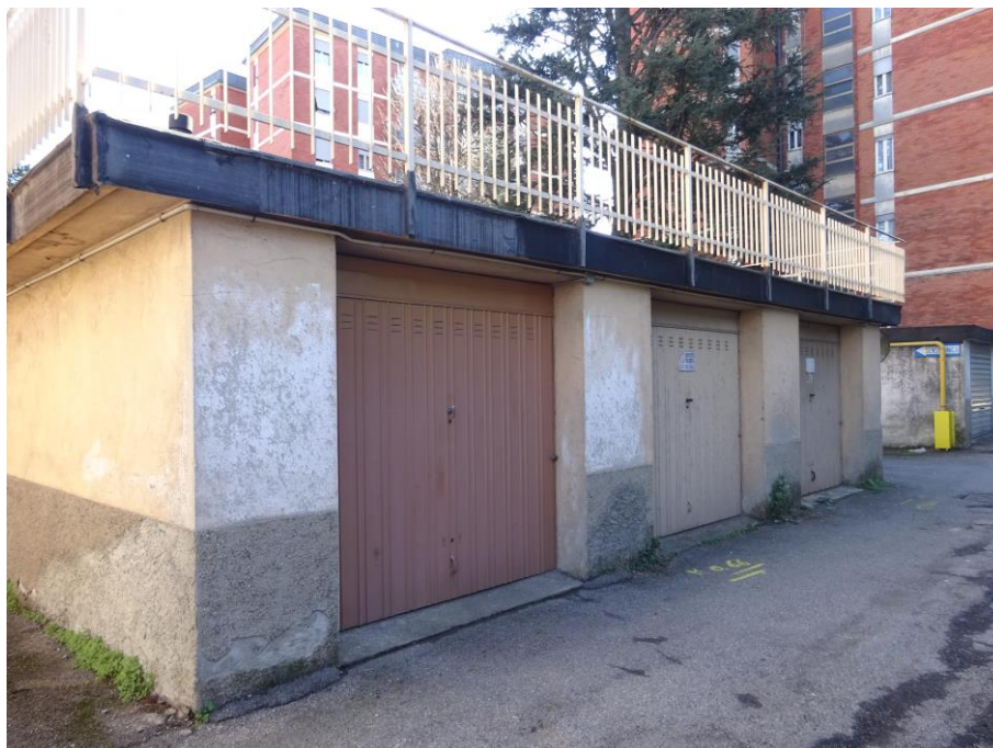
Corpo di fabbrica delle autorimesse
