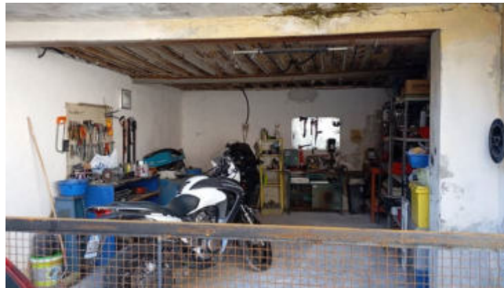
Vista interna del locale autorimessa
