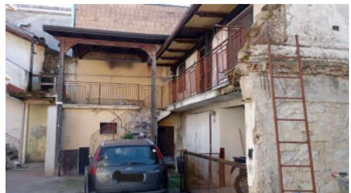
La scala che conduce al bilocale 1° piano
