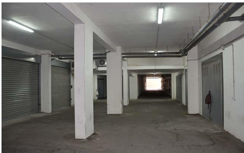
imm.2.06: corsia di manovra
