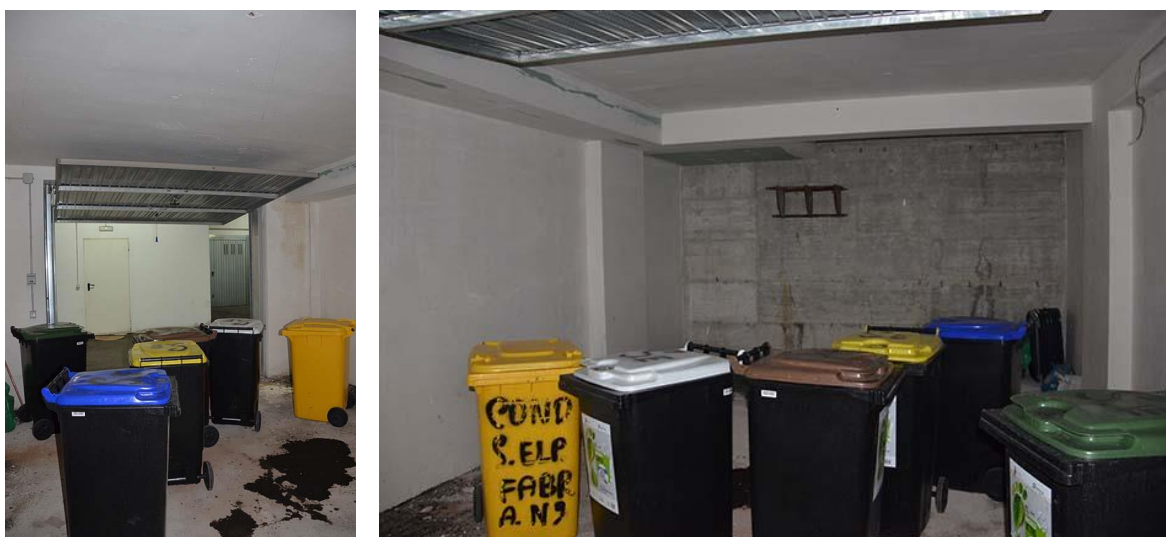
imm.2.09: interno del box
