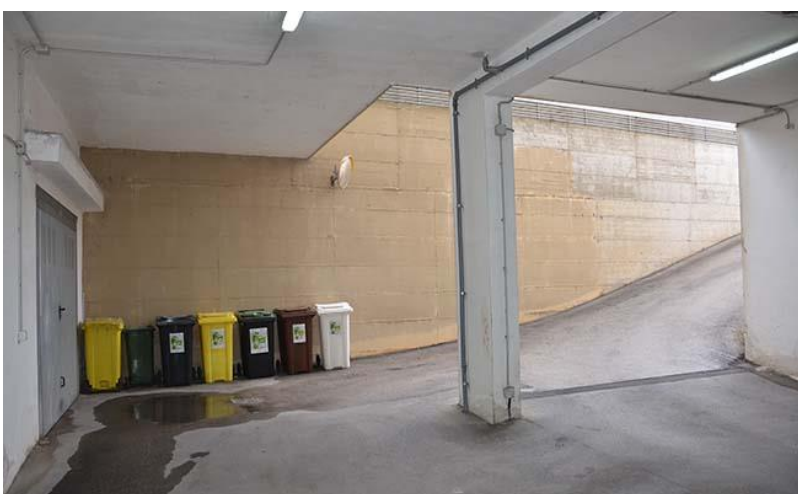
imm.2.07: rampa di uscita
