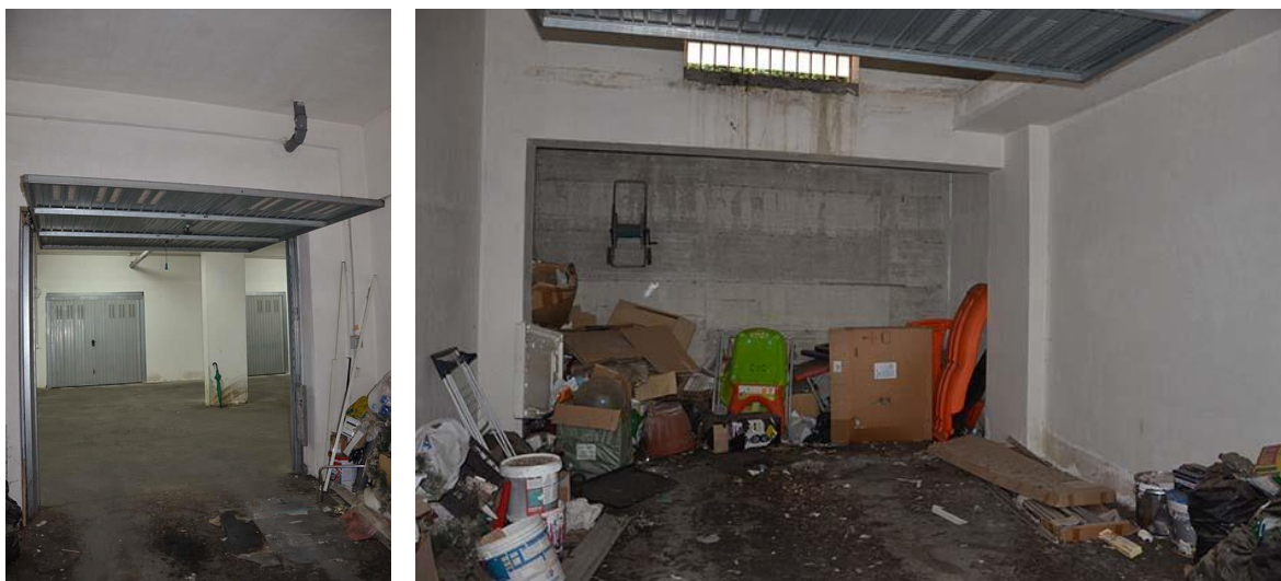
imm.2.09: interno del box
