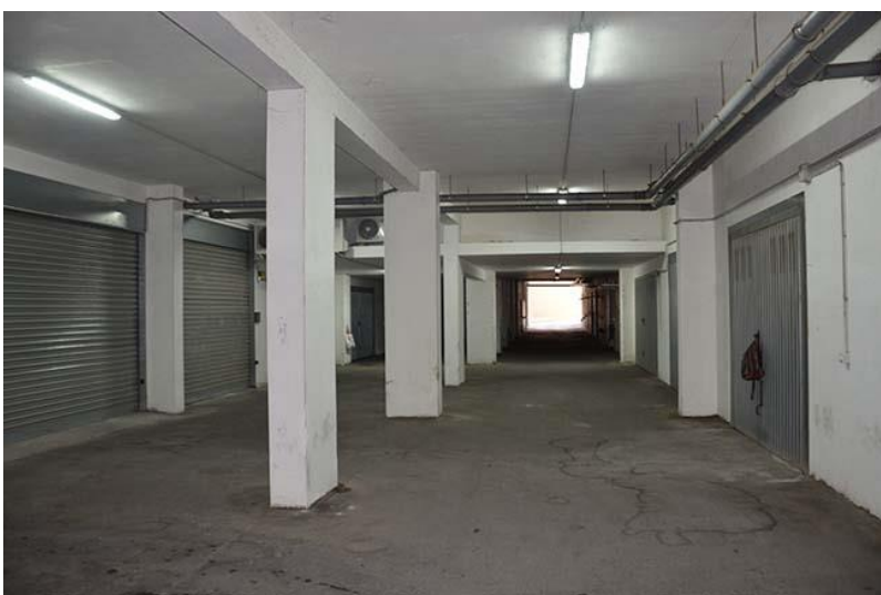
imm.2.06: corsia di manovra
