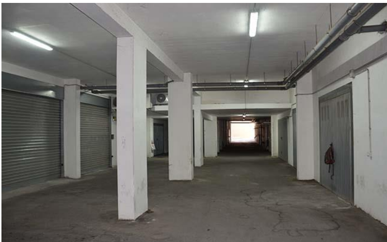
imm.2.06: corsia di manovra
