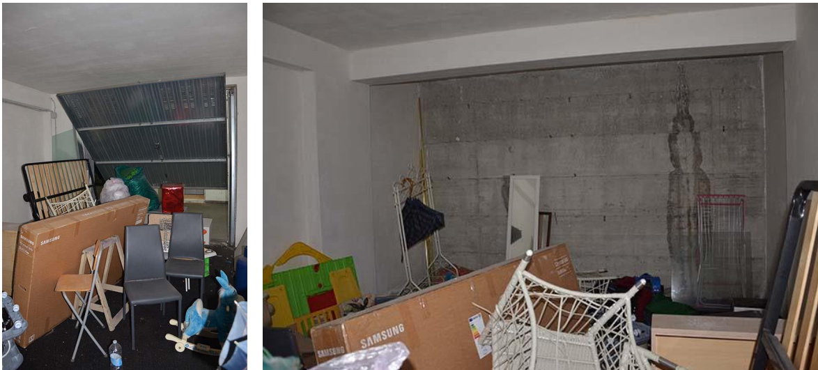
imm.2.09: interno del box
