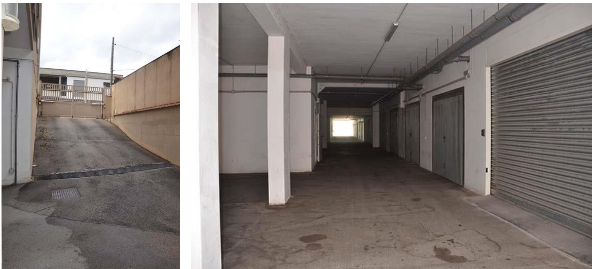
imm.2.05: rampa di ingresso al seminterrato e corsia di manovra
