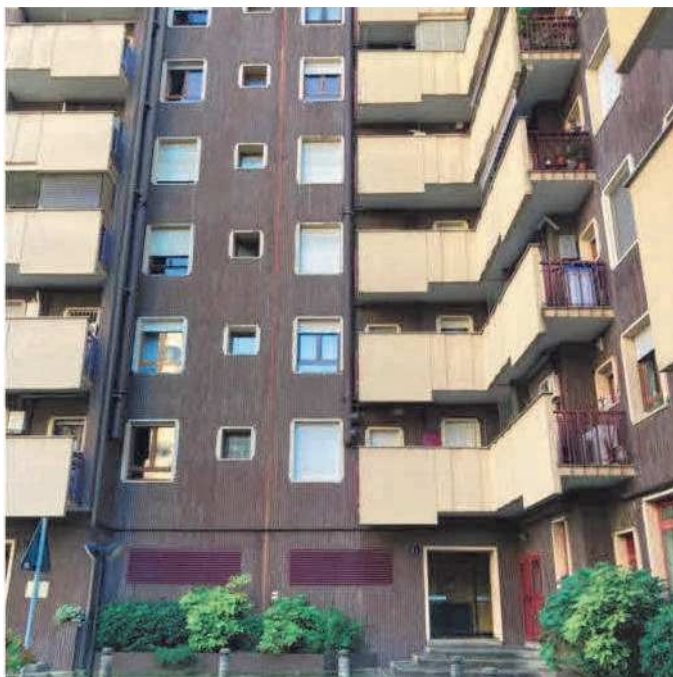
Vista facciata stabile
