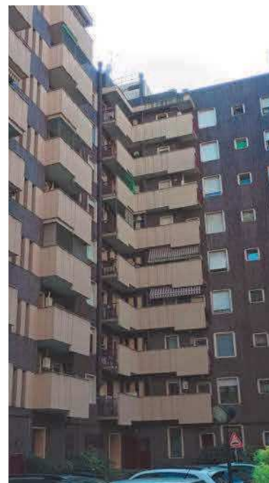
Vista facciata stabile
