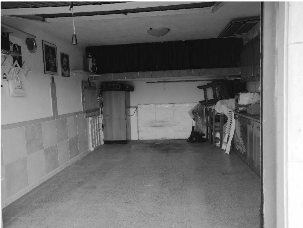
Foto n. 21 Interno Box auto
