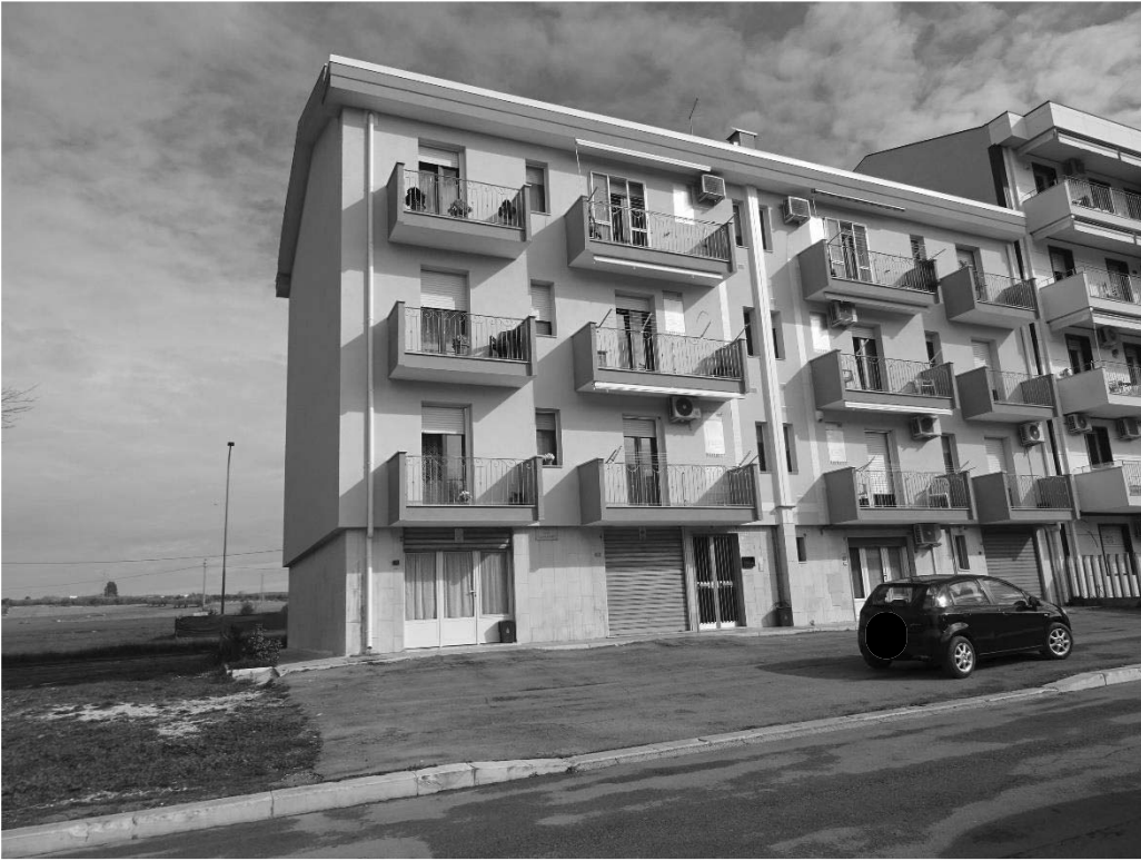
Foto n. 1 Prospetto Via P. Calamandrei n. 6
