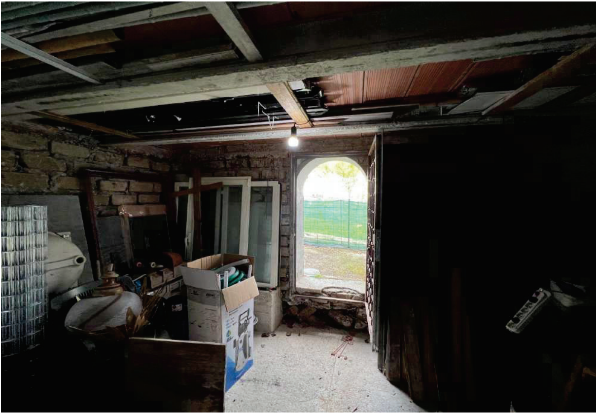
FOTO 13: Veduta interna vano deposito 2 piano S1
