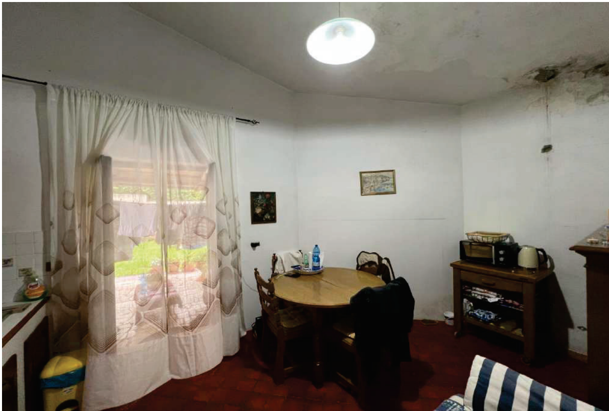
FOTO 5: Veduta interna vano cucina abitazione piano terra
