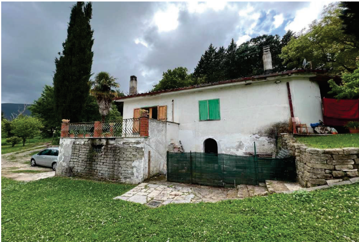
FOTO 2: Veduta esterna prospetto nord-est abitazione
