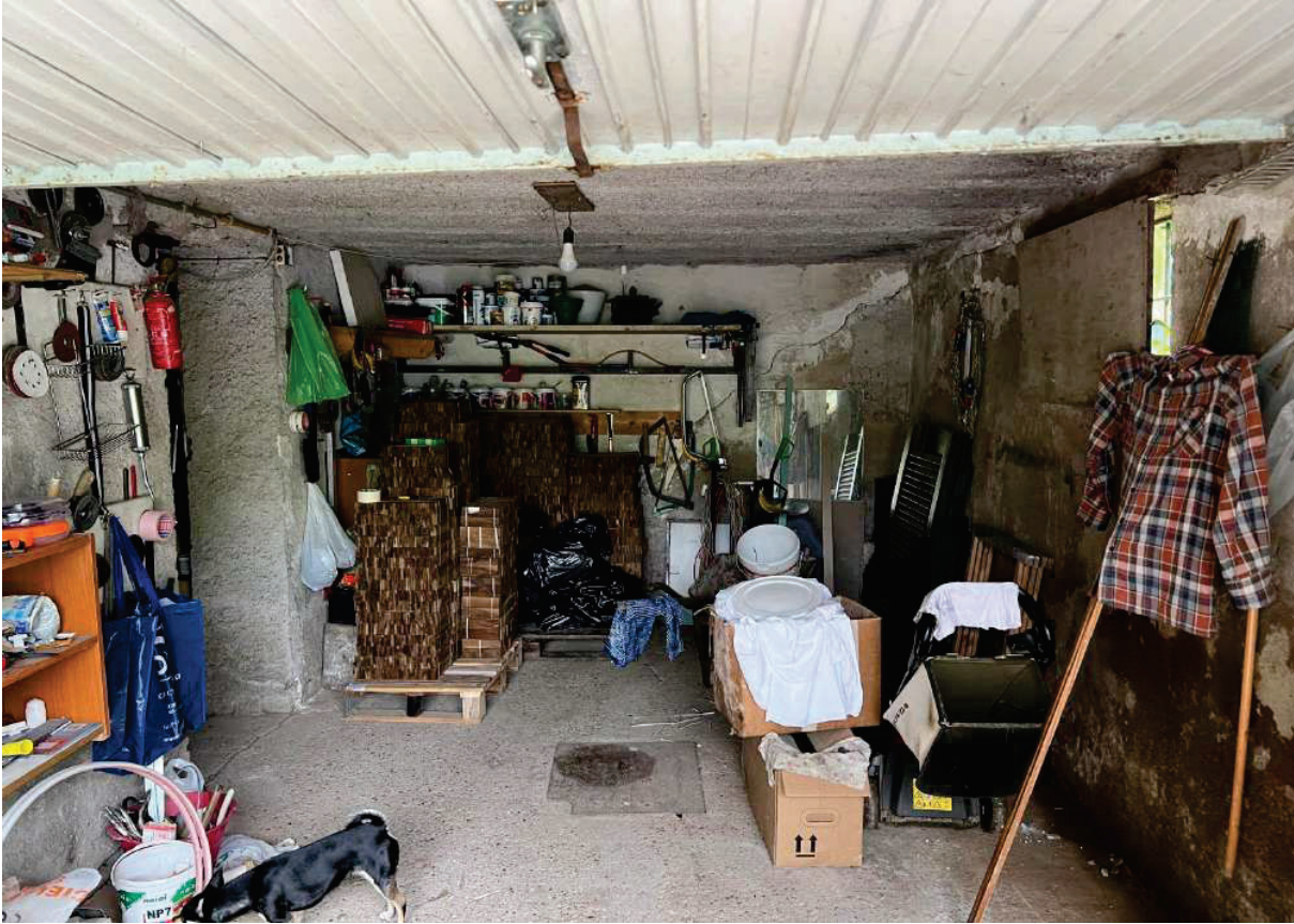
FOTO 11: Veduta interna vano garage piano S1
