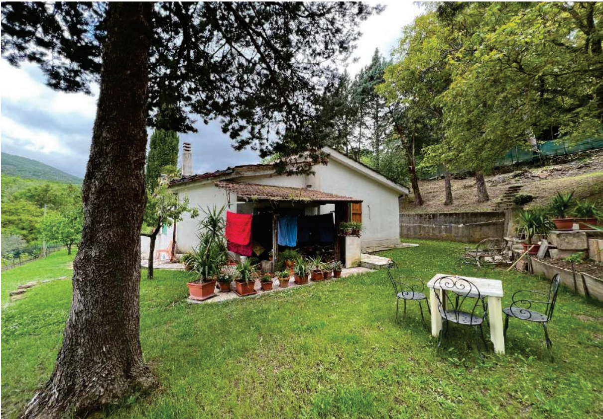
FOTO 3: Veduta esterna prospetto nord-ovest abitazione
