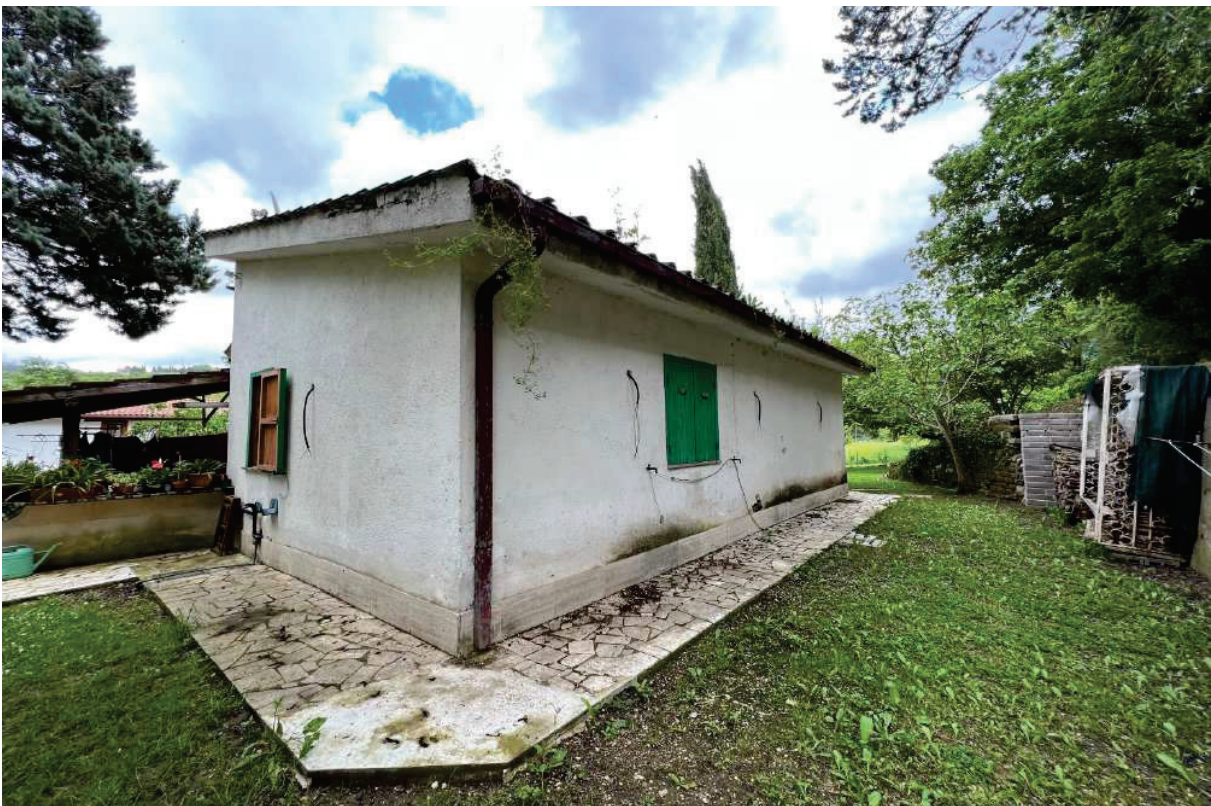
FOTO 4: Veduta esterna prospetto sud-ovest abitazione
