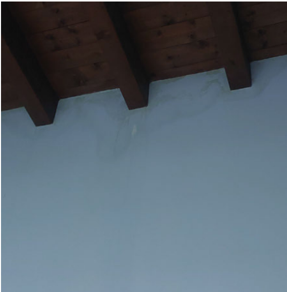
Vista dell'infiltrazione localizzata n. 1 uffici
