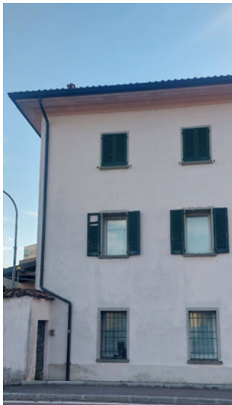
Vista della facciata da vi XXV Aprile
