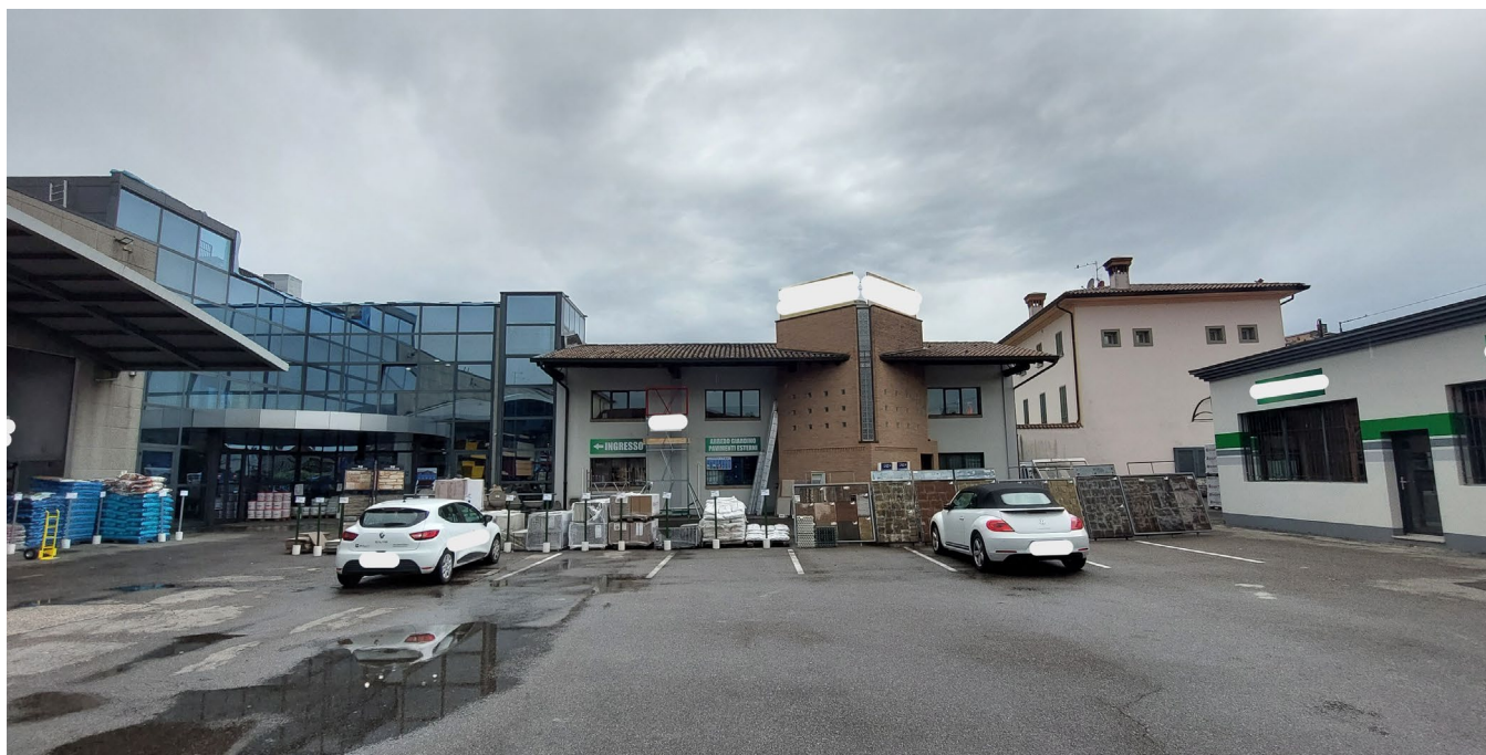
Vista sala esposizione e uffici da corte interna
