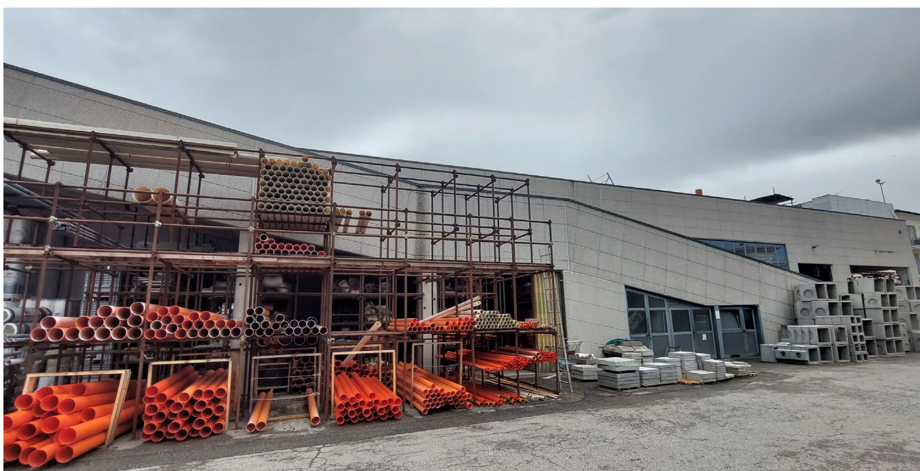
Vista magazzino rampa per accesso al parcheggio in copertura
