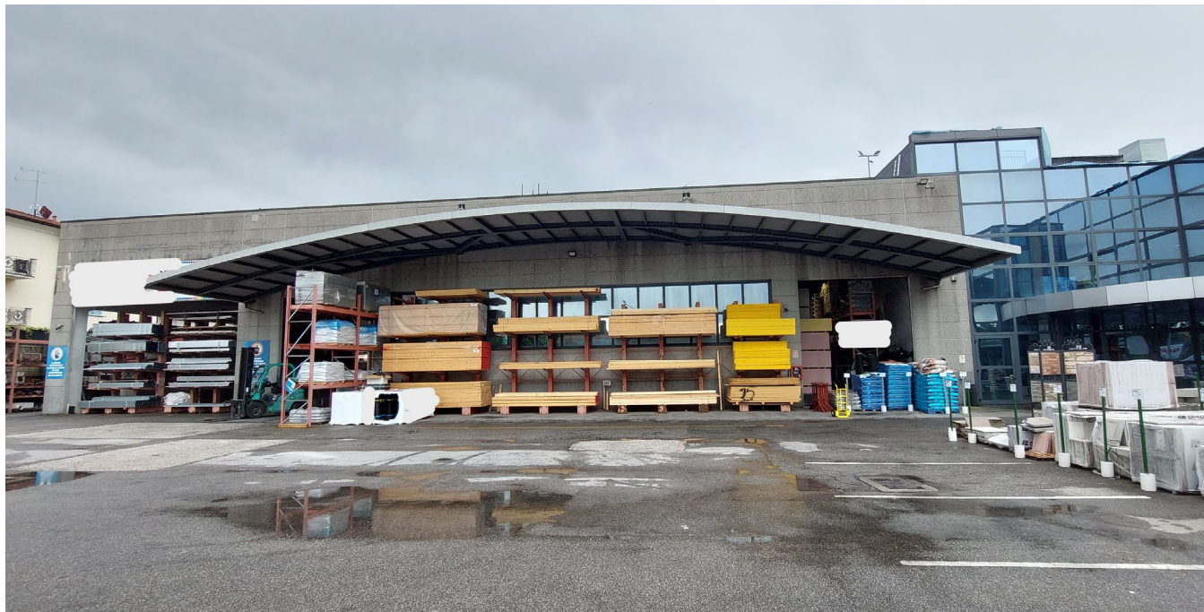
Vista magazzino da corte interna
