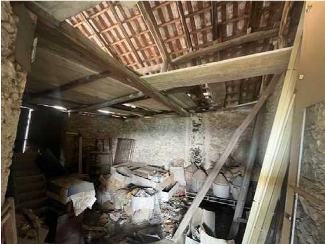
FG 25 MAPP 35 – P.1. – VISTA INTERNA
