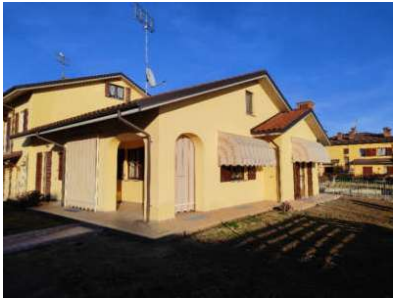
Foto 2 – Vista dall'esterno con il giardino di pertinenza
