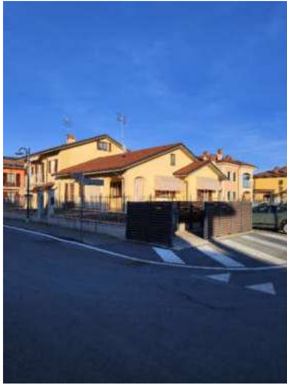
Foto 1 – Vista dalla Via S. Forni
