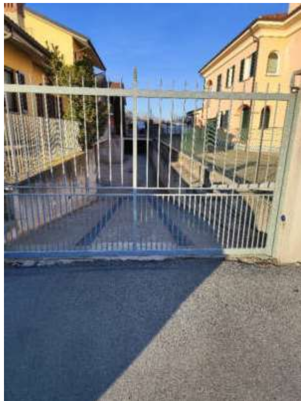
Foto 3 – la rampa di accesso all'autorimessa
