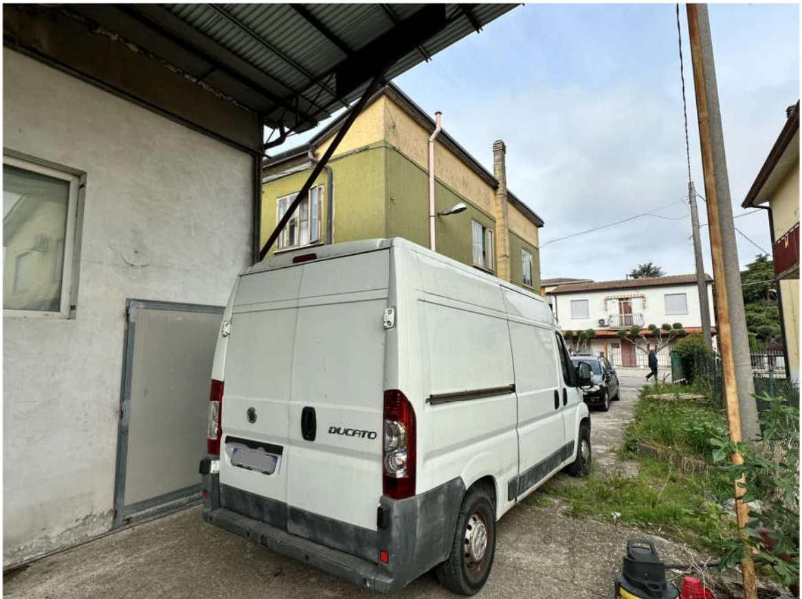
Foto 46 - tettoia laboratorio con viale di uscita
