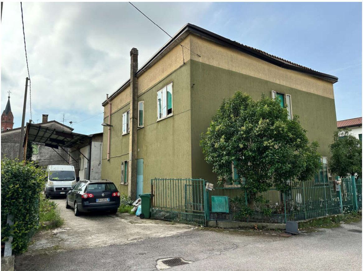
Foto 2 - esterno dell'edificio residenziale - carraio laboratorio
