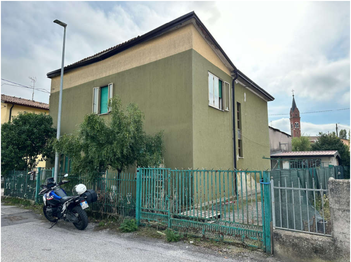
Foto 1 - esterno dell'edificio residenziale - carraio abitazione
