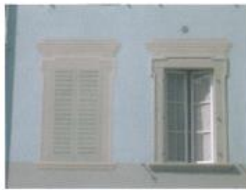
finestra dipinta e particolare cornici
