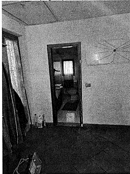
Disimpegno piano primo
