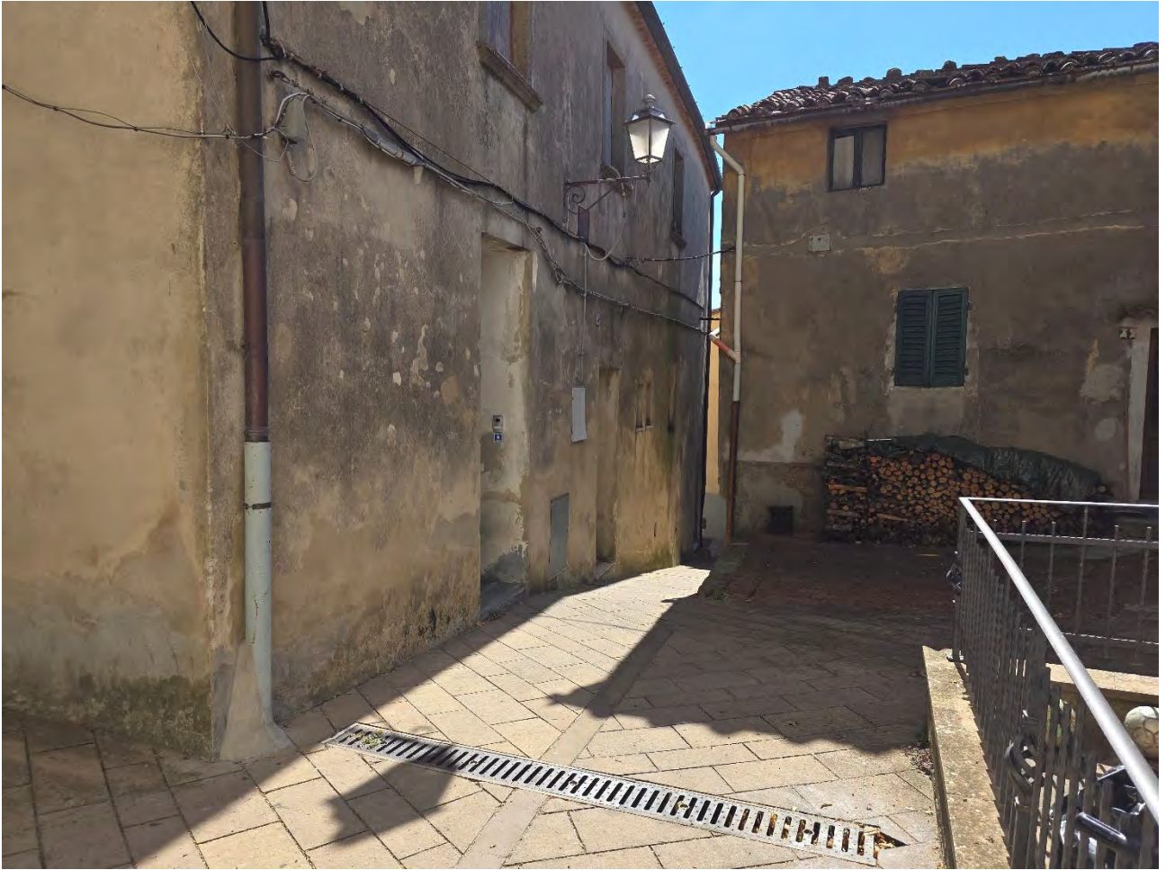
Via IV Novembre (spigolo a monte dell'edificio)
