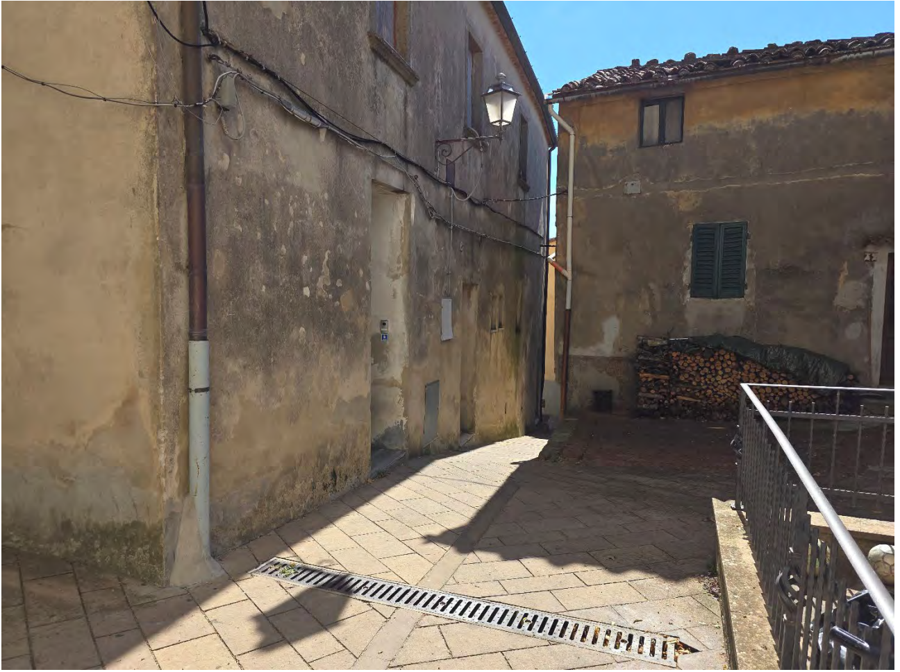
Via IV Novembre (spigolo a monte dell'edificio)
