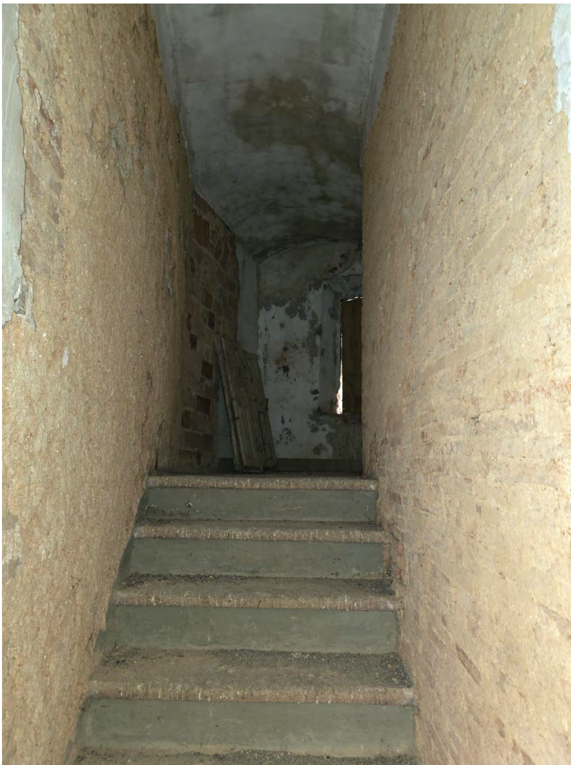
Rampa di accesso al piano superiore
