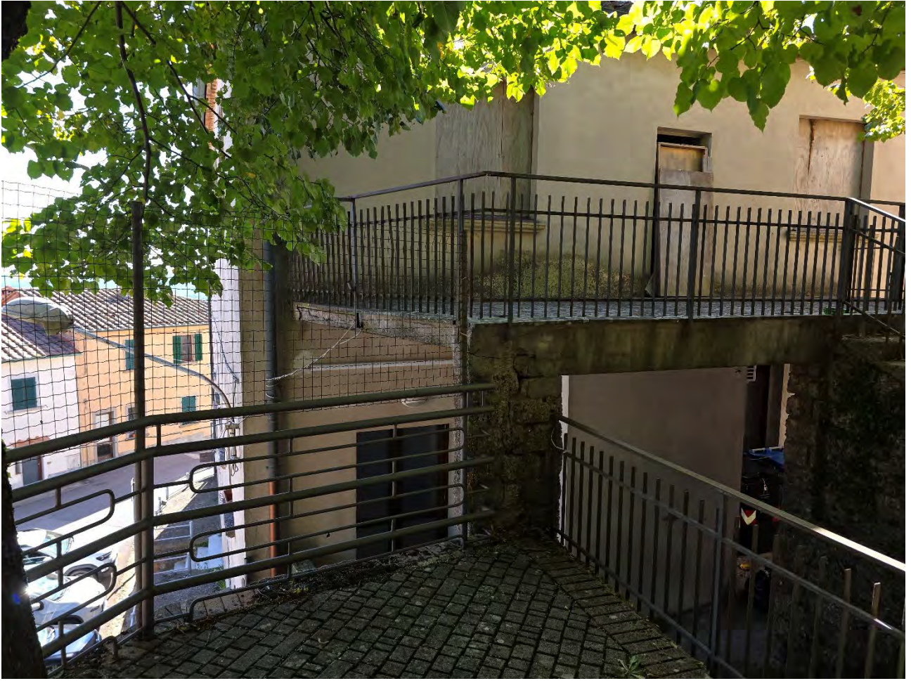
Giardini pubblici lato a monte vista sulla sottostante Piazza Armando Diaz
