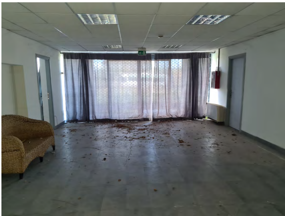
Foto n.001 – Piscina termale, ingresso piano terra
