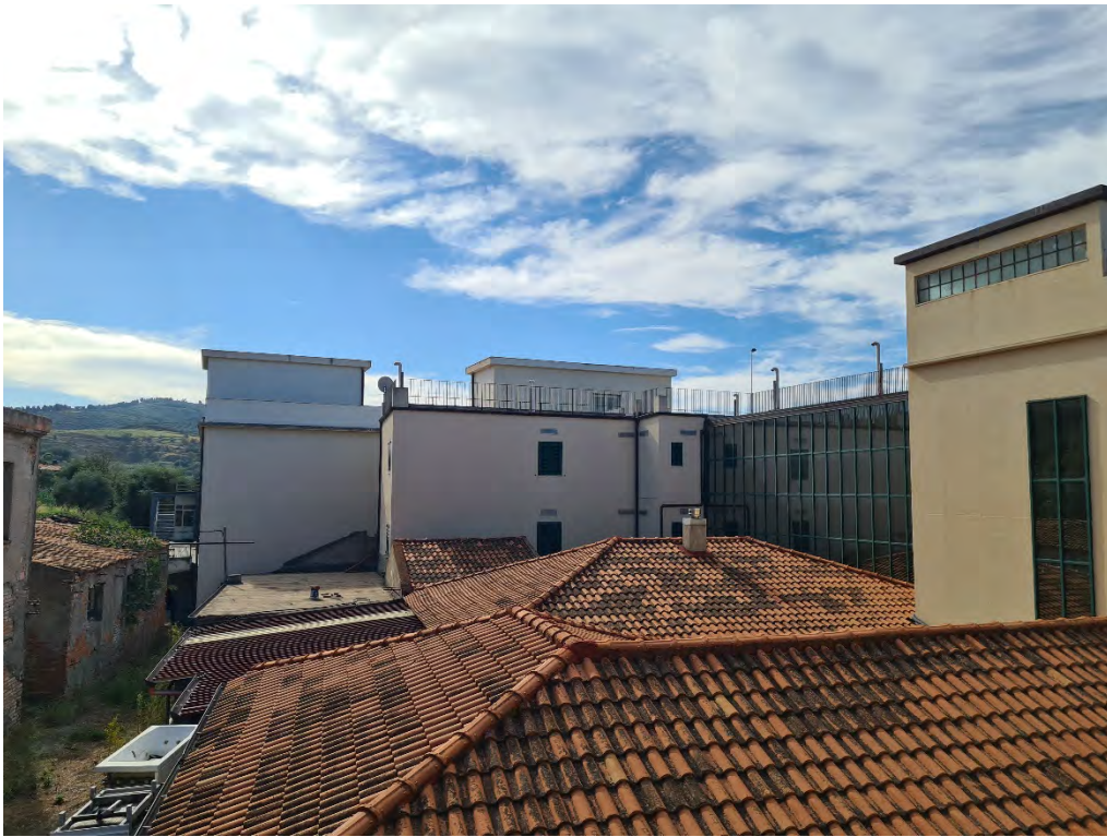
Foto n.006 - Corpo A1, prospetto posteriore
