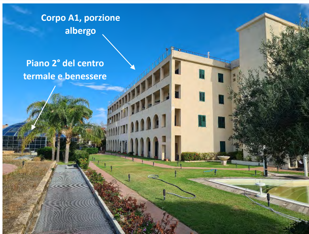
Foto n.001 – Corpo A1, porzione albergo
