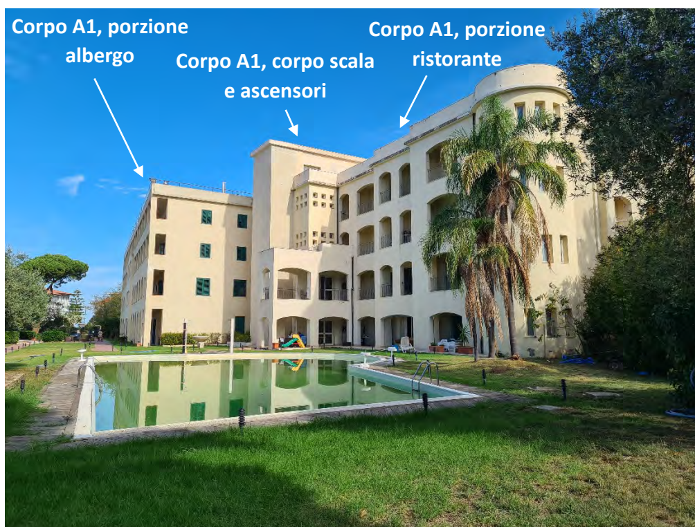
Foto n.002 – Corpo A1, porzione ristorante in primo piano, porzione albergo in secondo piano
