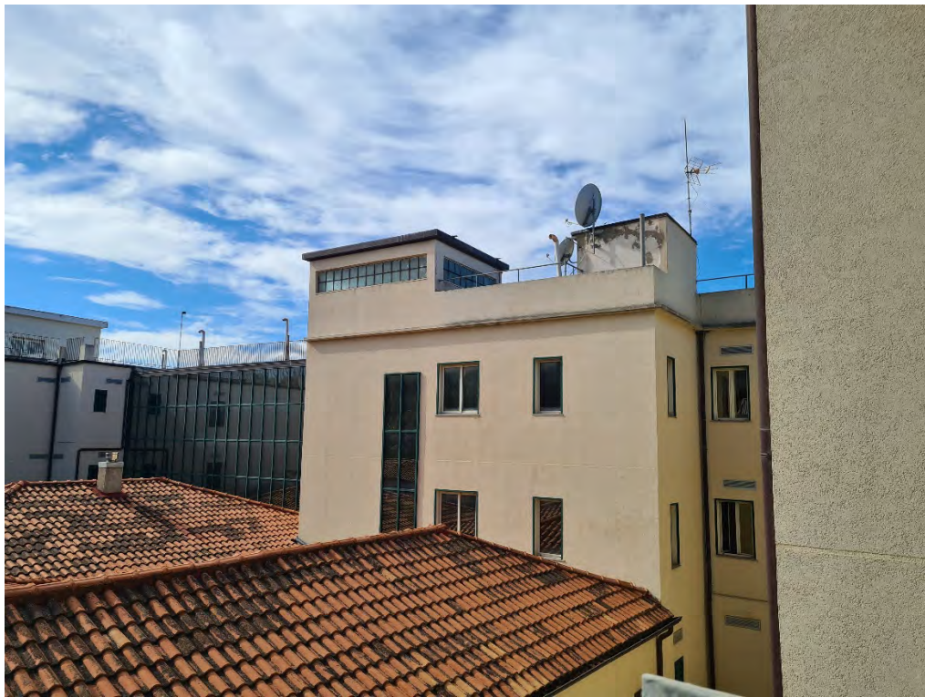
Foto n.007 - Corpo A1, prospetto posteriore
