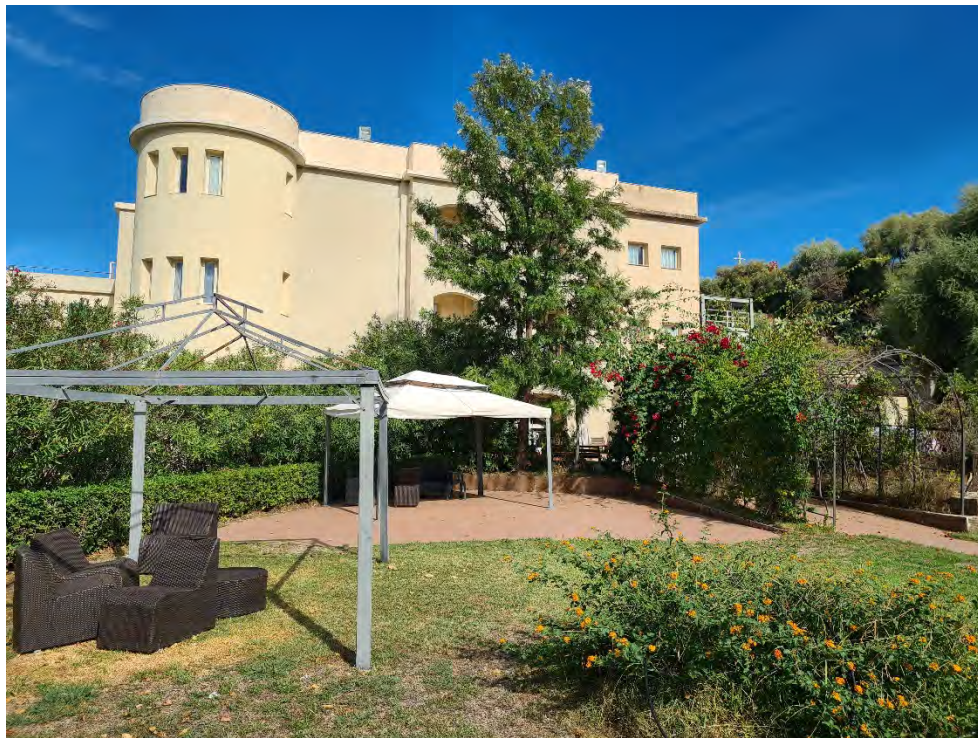
Foto n.005 – Corpo A1, porzione ristorante
