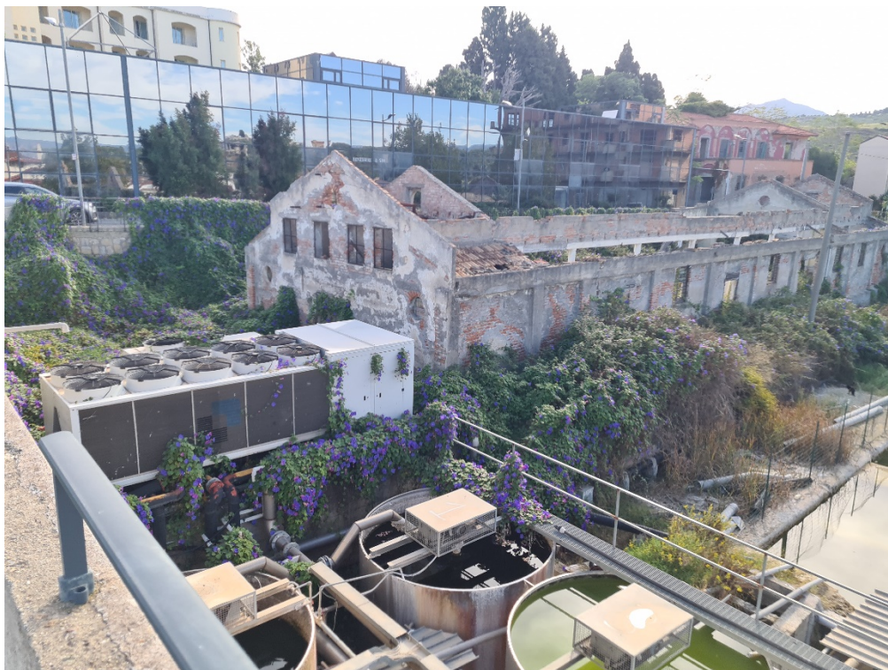
Foto n.001 – Immobile fatiscente e terreni circostanti
