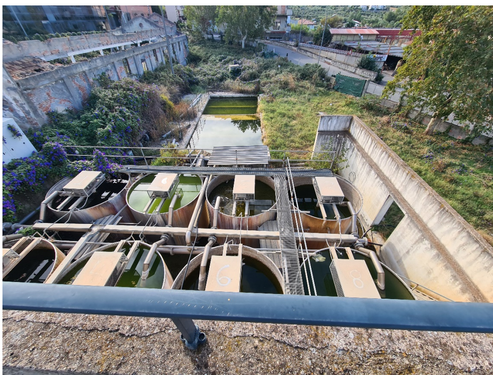
Foto n.002 - Immobile fatiscente e terreni circostanti
