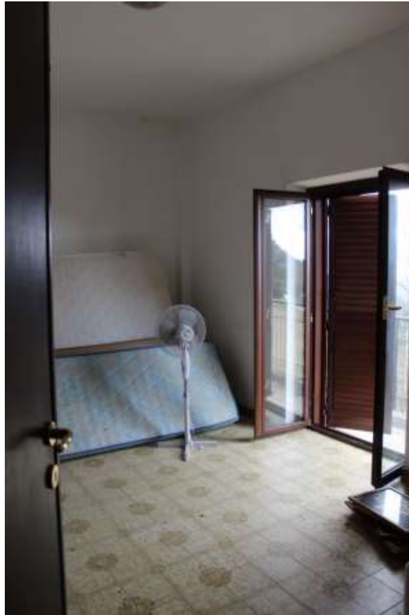
FOTO 15 – Camera 1 (Piano 1) - Corpo “A”
