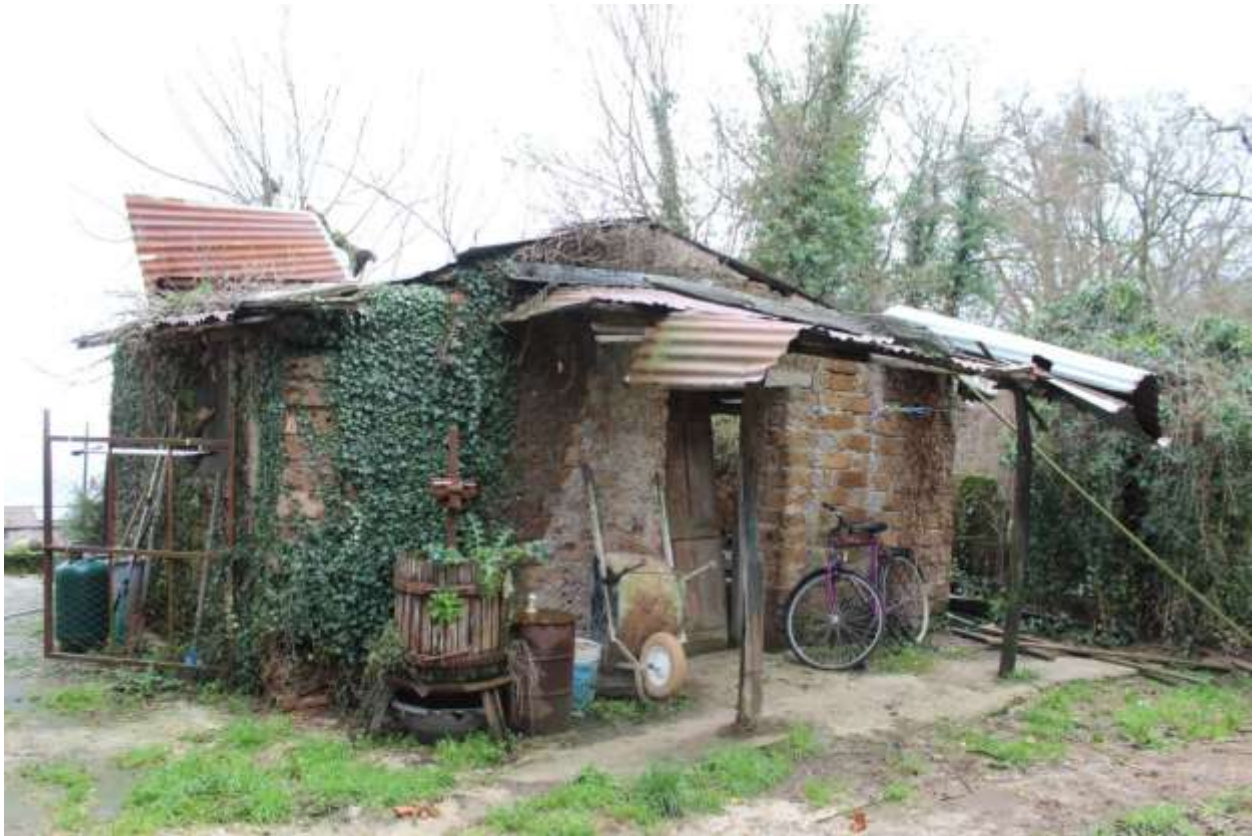
FOTO 5 – Magazzino (Lato Ovest) Corpo “C”
