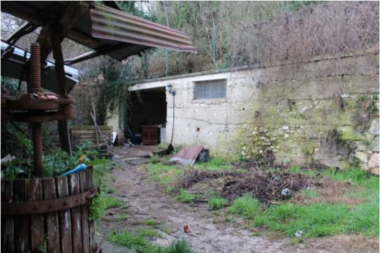
FOTO 7 – Ingresso Rimessa (Lato Ovest) Corpo “B”
