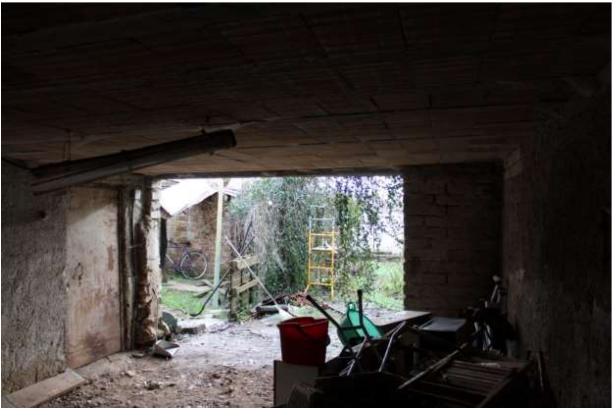
FOTO 8 – Rimessa - Corpo “B”
