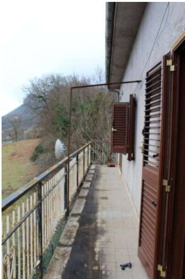
FOTO 11 – Balcone (Piano 1) - Corpo "A"
