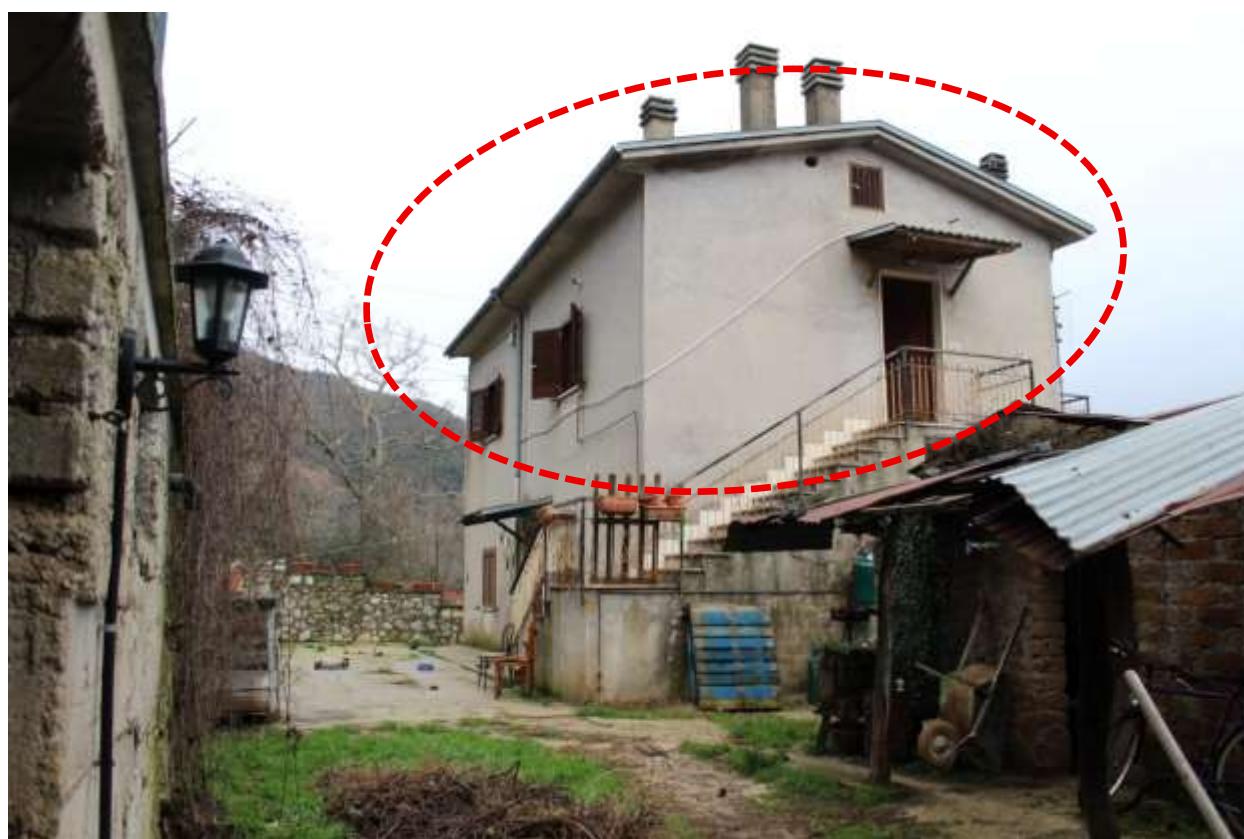
FOTO 4 – Abitazione (Lato Sud) Corpo “A”
