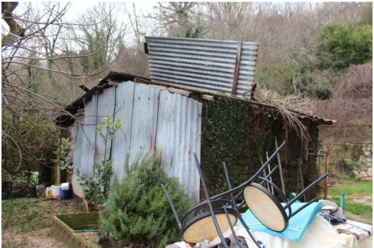
FOTO 6 – Magazzino (Lato Est) Corpo “C”
