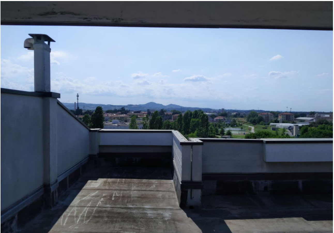
Fot.6 - Vista del lastrico solare.
