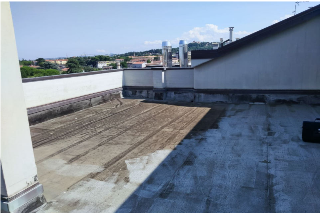
Fot.4 - Vista del lastrico solare
