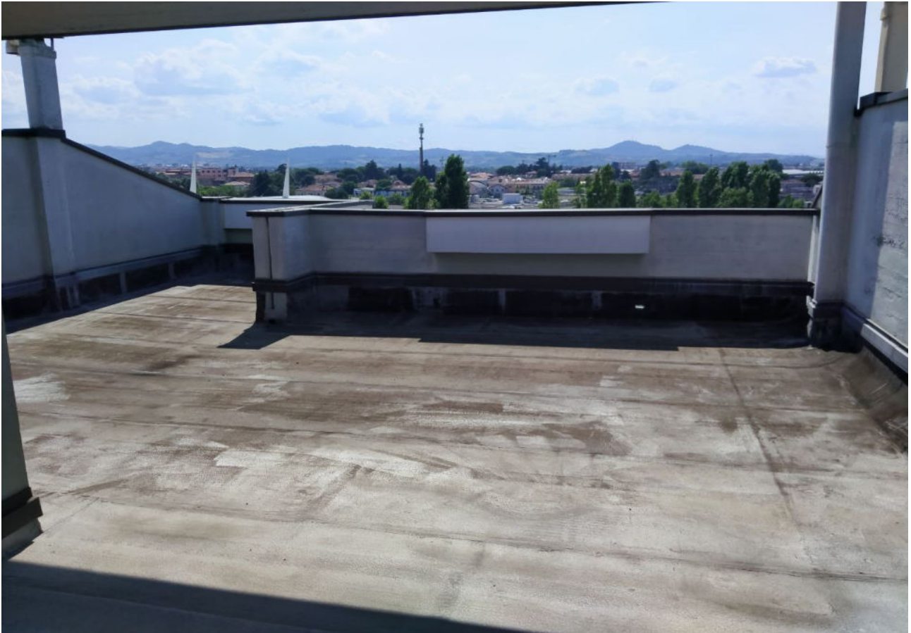
Fot.4 - Vista del lastrico solare.
