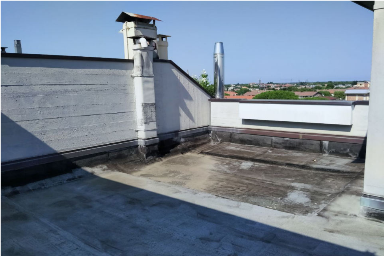
Fot.5 - Vista del lastrico solare
