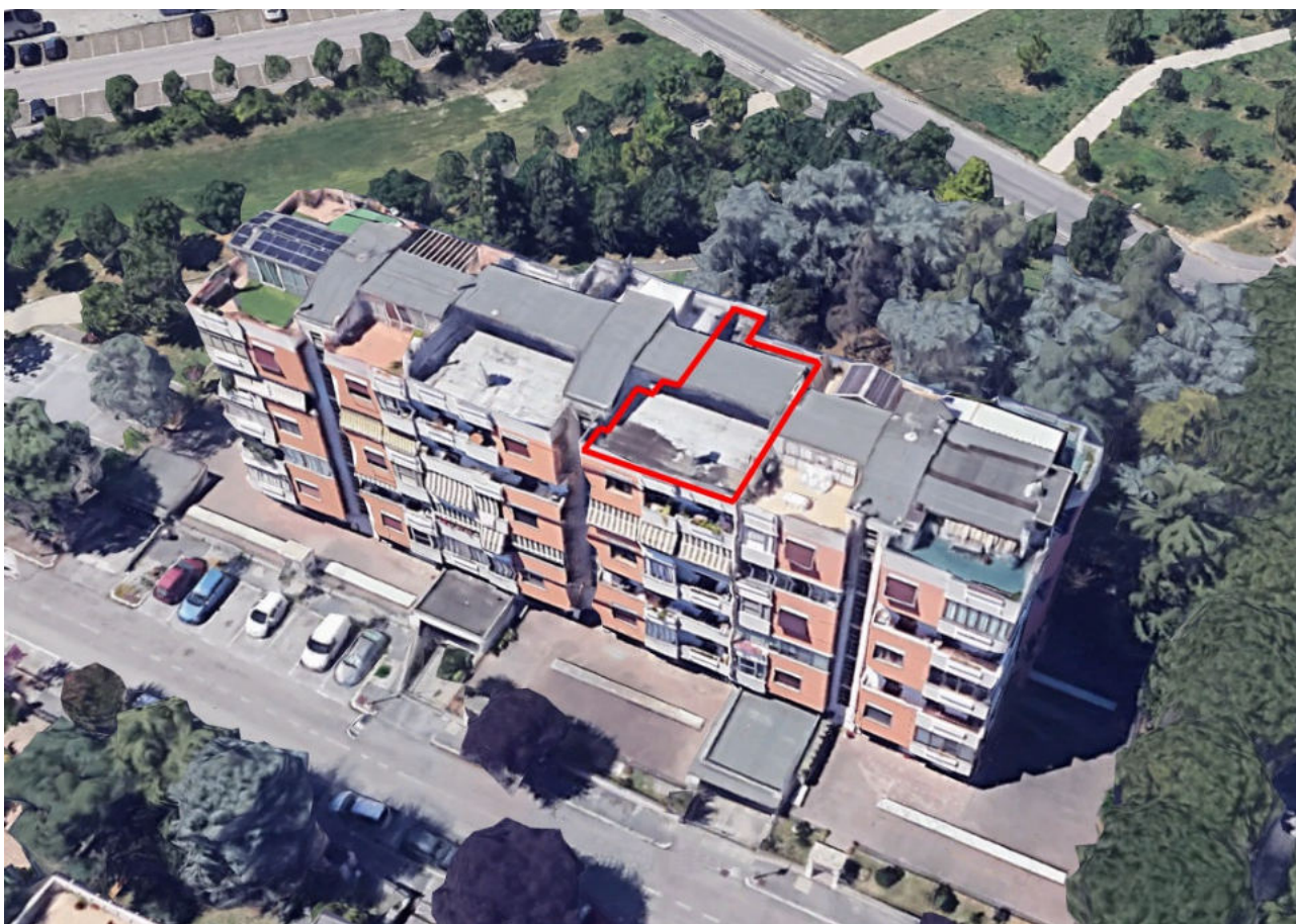
Fot.1- Individuazione del complesso residenziale ****OMISSIS**** in Via Sacco e Vanzetti . Con la bordatura rossa il lastrico solare.
