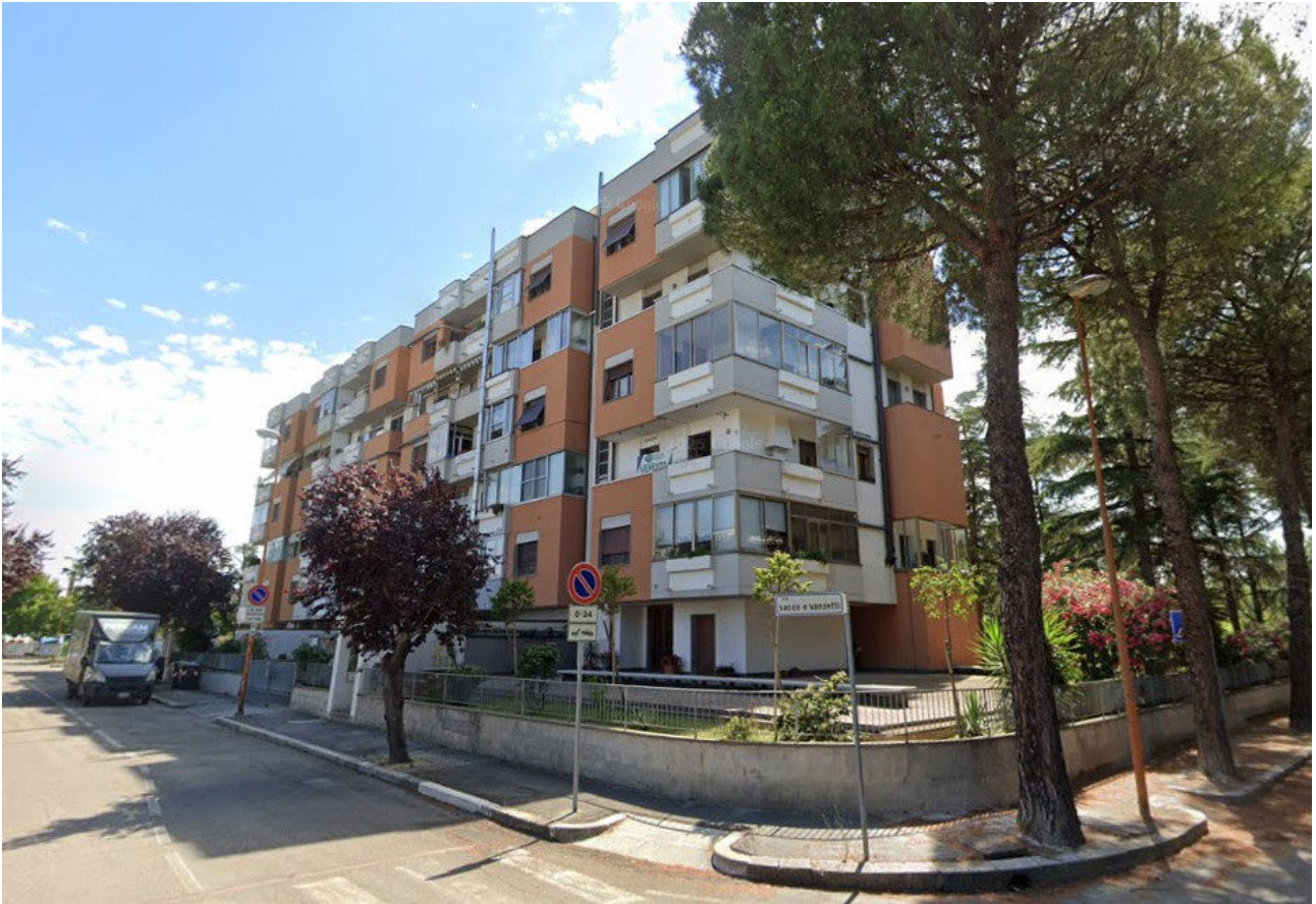
Fot.2 - Vista del complesso residenziale "****OMISSIS****" da Via Sacco e Vanzetti.
