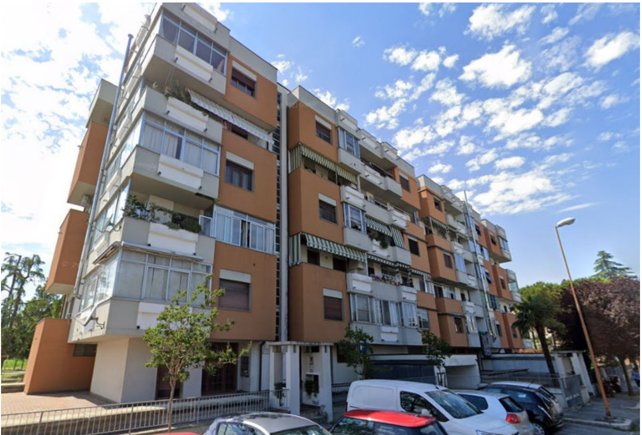
Fot.3 - Vista del complesso residenziale "****OMISSIS****" da Via Sacco e Vanzetti.
