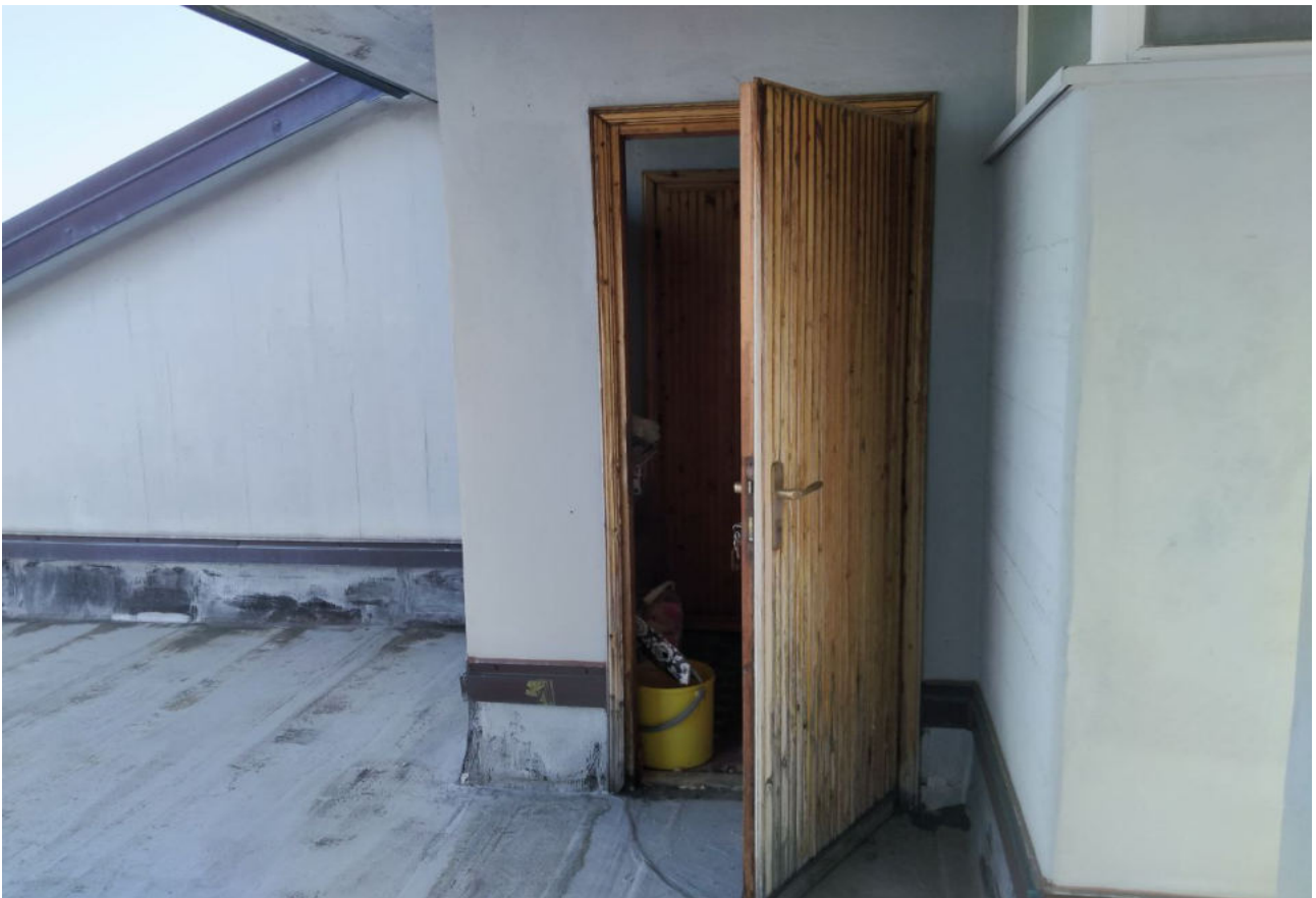
Fot.8 - Vista dell'ingresso al lastrico solare dal vano scale condominiale.
