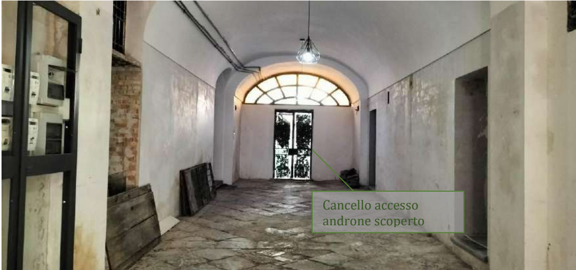
Androne comune coperto_ cancello ingresso androne scoperto
