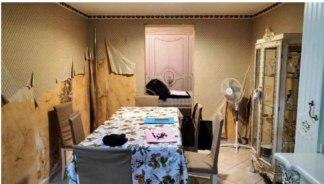
Particolare parete zona soppalcata
