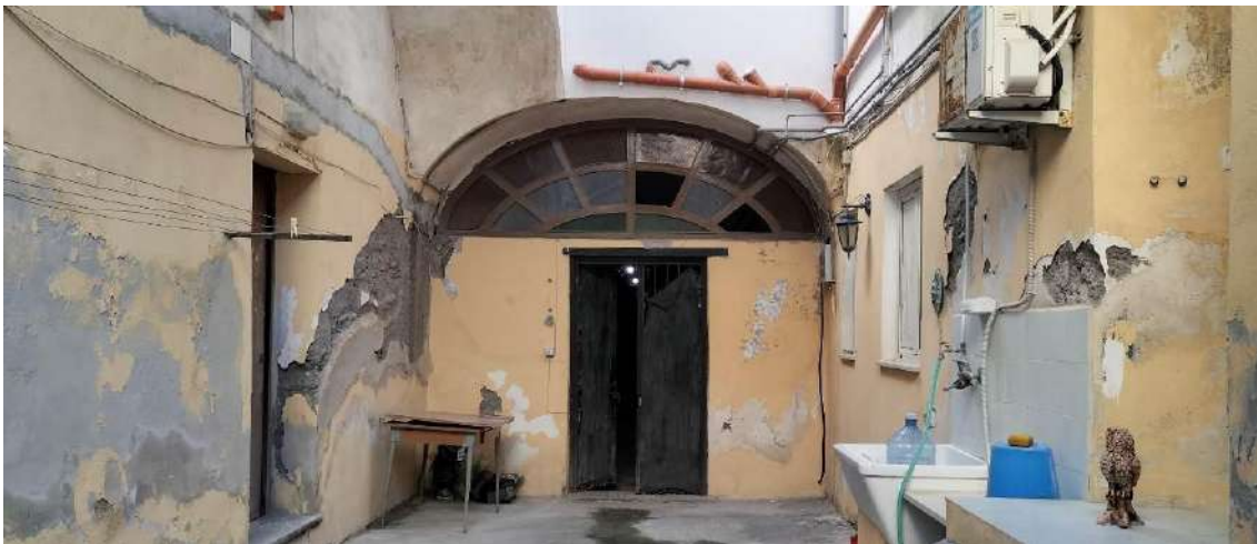
Androne comune scoperto_ cancello ingresso lato interno
