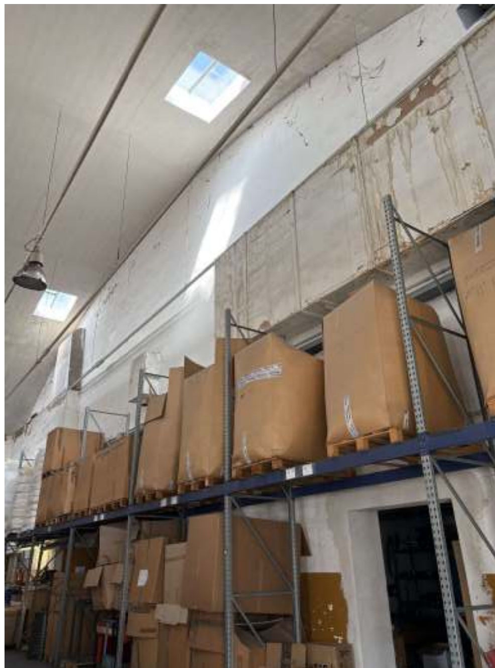
Ampio magazzino - scaffalature
