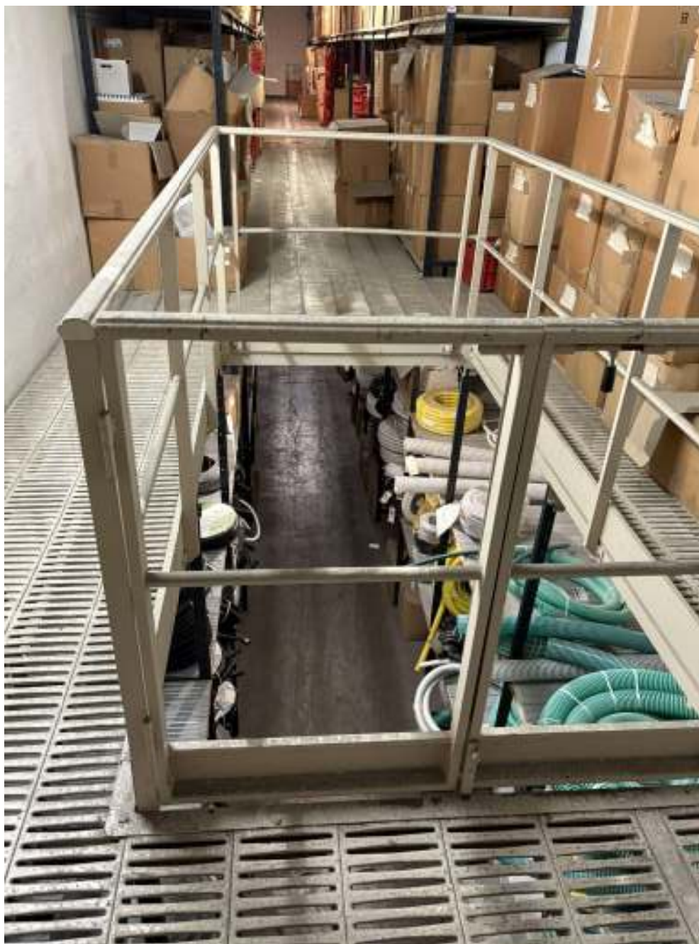
Ampio soppalco zona disimpeno
