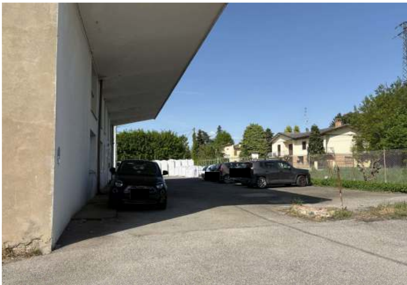
Area esterna - lato strada
