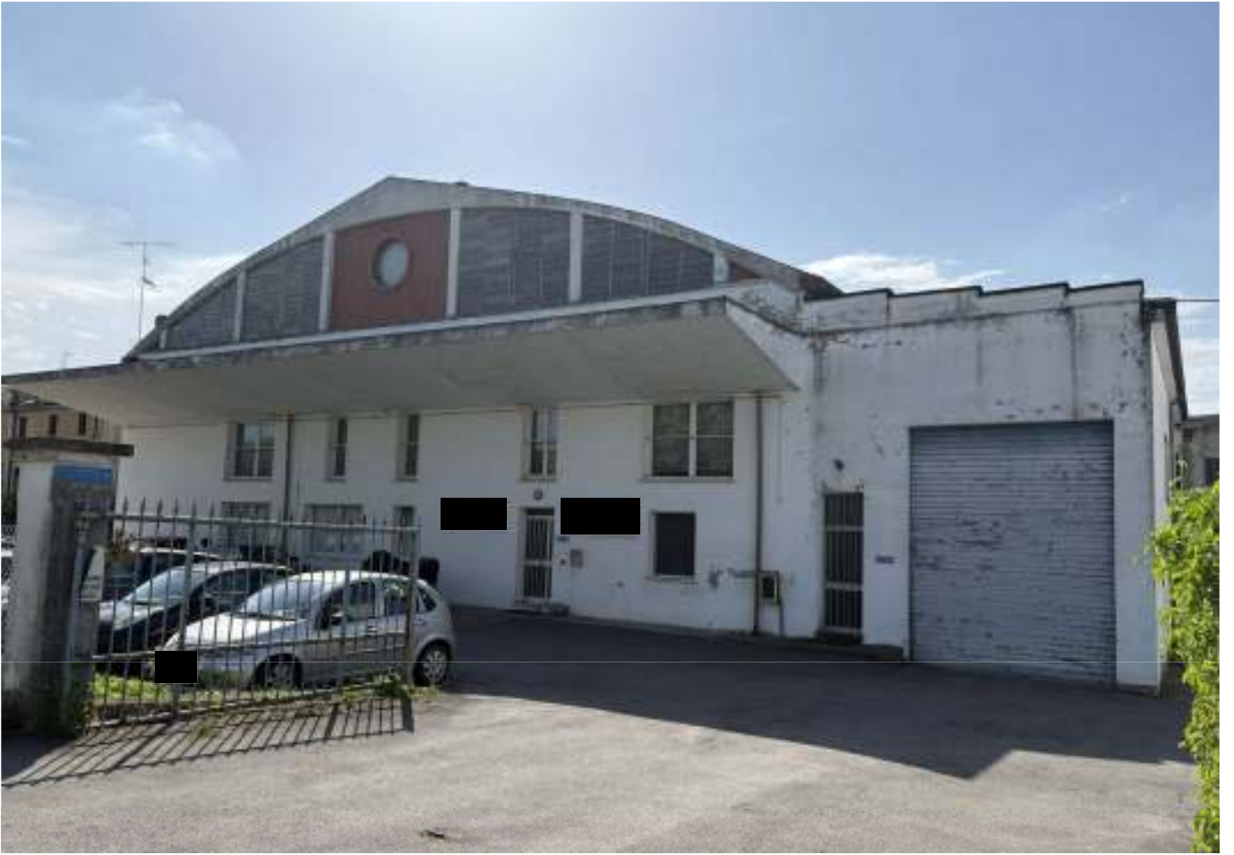
Ingresso da via Batia
