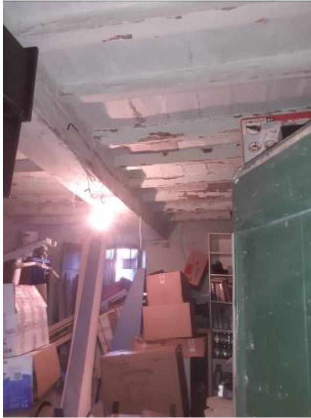
7. Interno piano terreno : stanza uso cantina-ripostiglio
