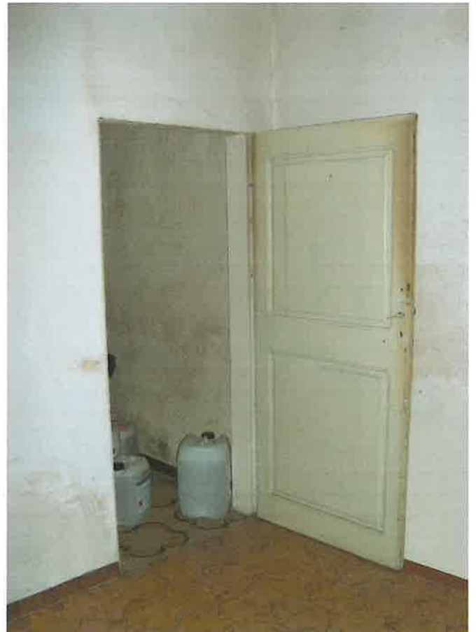
FOT. 8 - APERTURA DI COLLEGAMENTO FRA LETTO E CUCINA, A PIANO PRIMO, CHE VERRA' CHIUSA.
