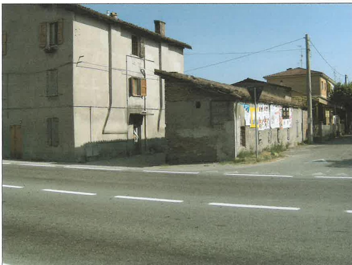
FOT. 4 - VISTA D'INSIEME DEI DUE FABBRICATI ( VERSO LA VIA EMILIA)
