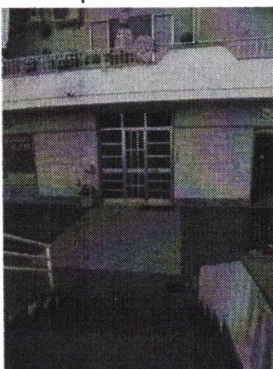
Portone ingresso alloggi
