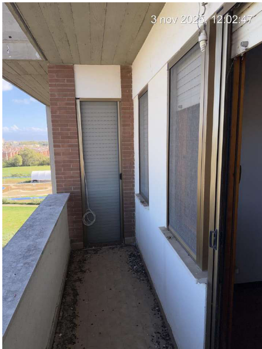
FOTO 19 – BALCONE POSTERIORE (APPARTAMENTO SUB. 37)
