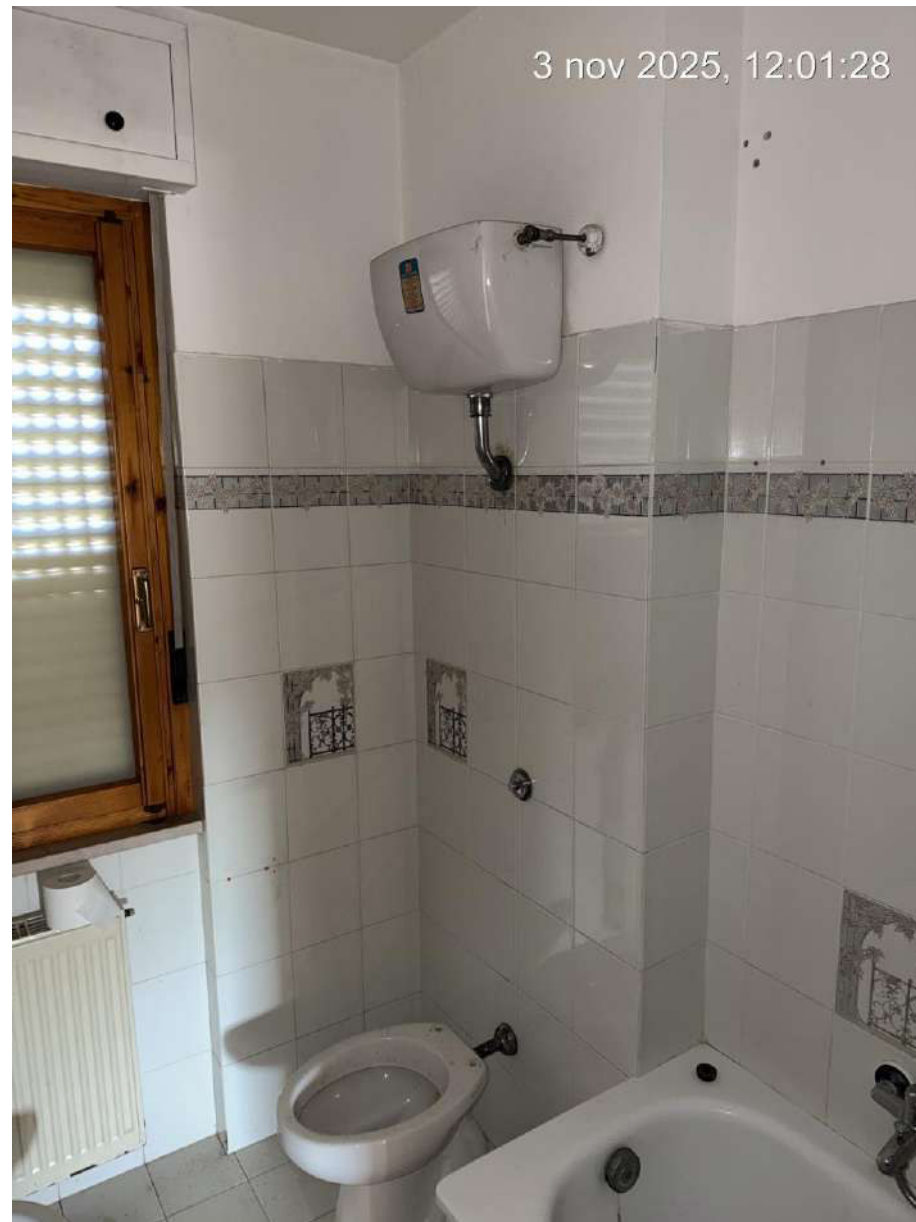
FOTO 14 – W.C. (APPARTAMENTO SUB. 37)
