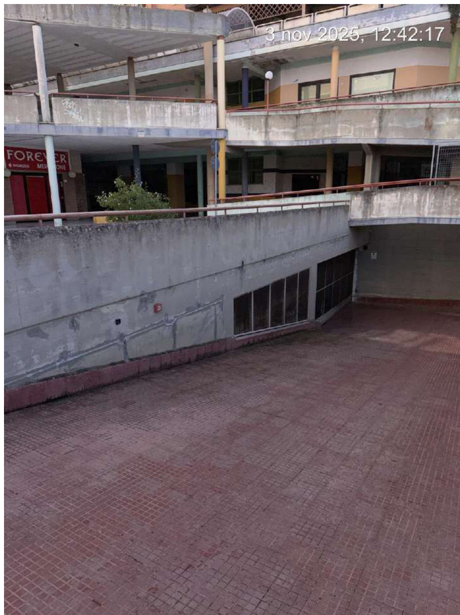
FOTO 33 – RAMPA DI ACCESSO AL POSTO AUTO SUB. 112
