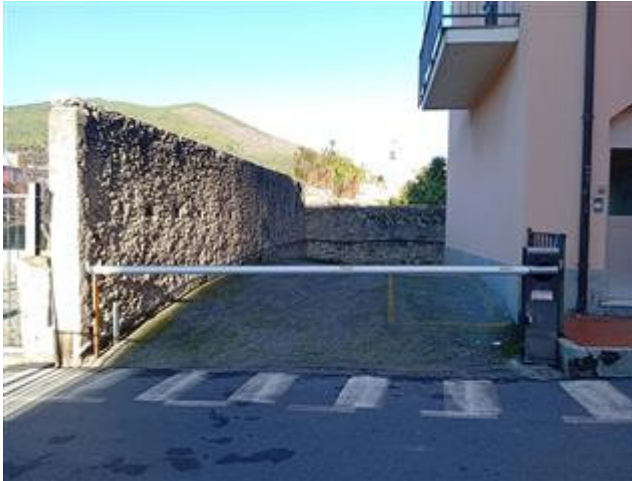
Accesso condominiale al piano interrato
