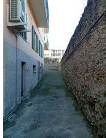
Rampa di accesso
