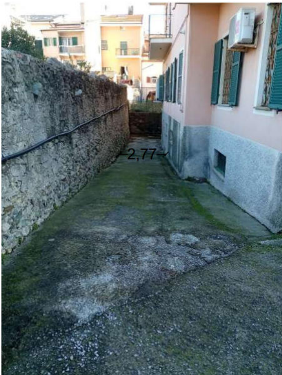
03 - Rampa di accesso al piano interrato
