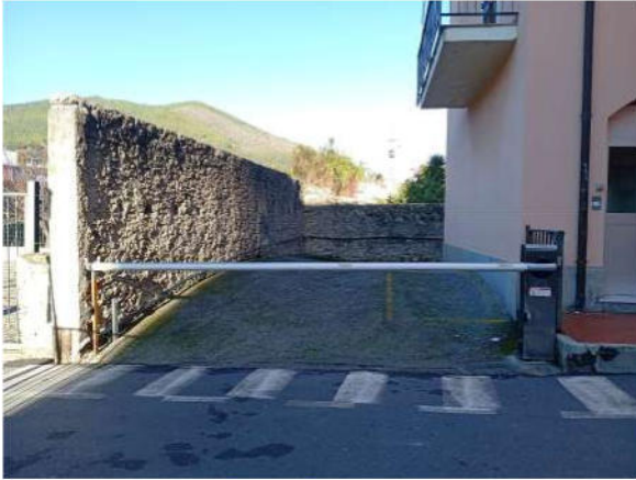
01 - Sbarra di accesso al piano interrato
