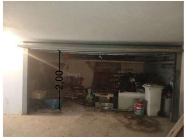
06 - Ingresso al box
