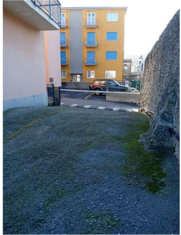
02 - Rampa di accesso
