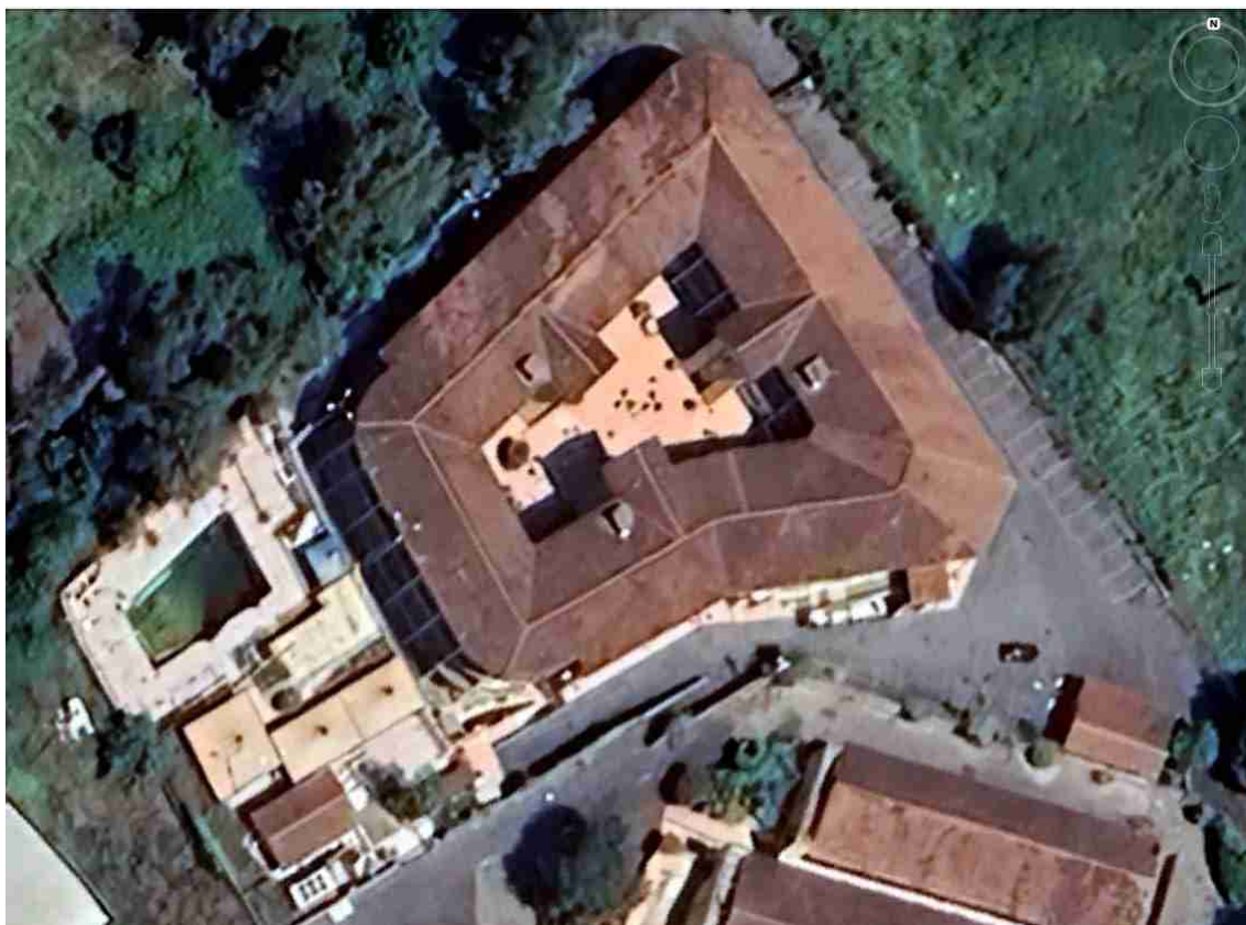
L'edificio principale e la zona piscina a sud-ovest dello stesso
