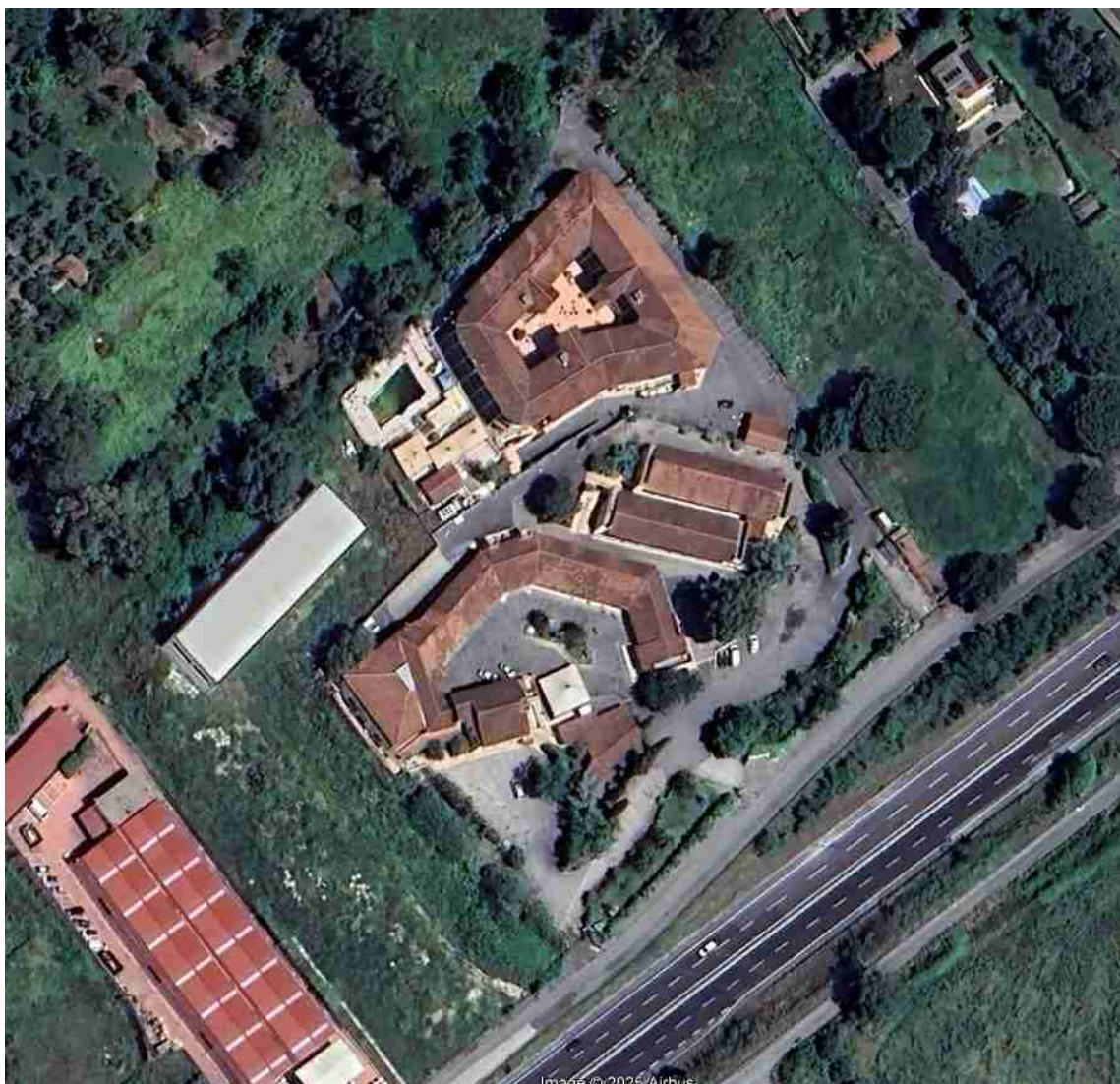
Il complesso nella sua interezza, residence a nord e albergo a sud
