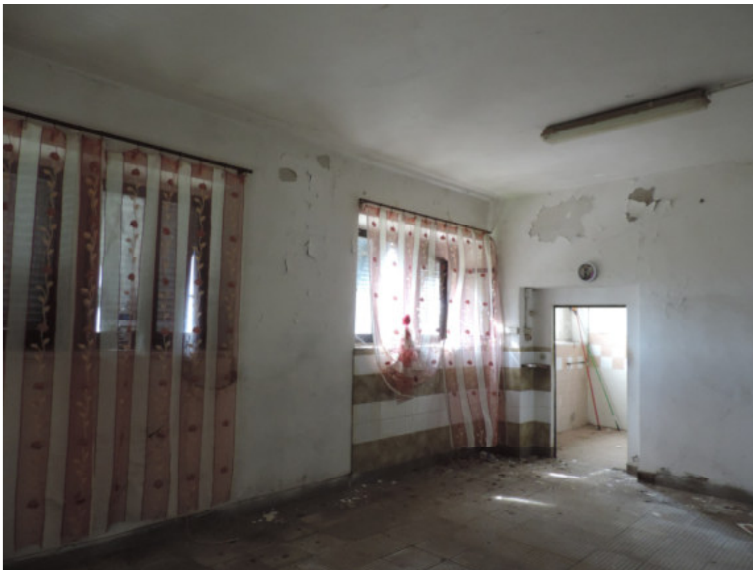
INTERNO PIANO TERRA
