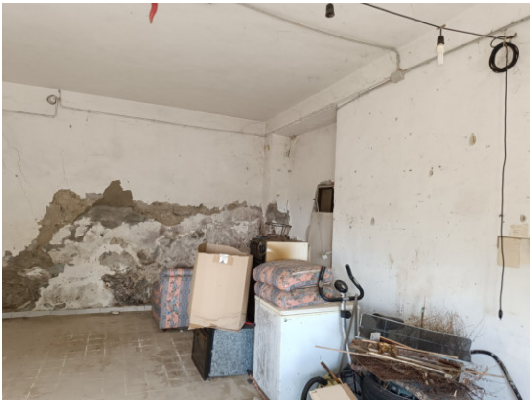
INTERNO PIANO TERRA
