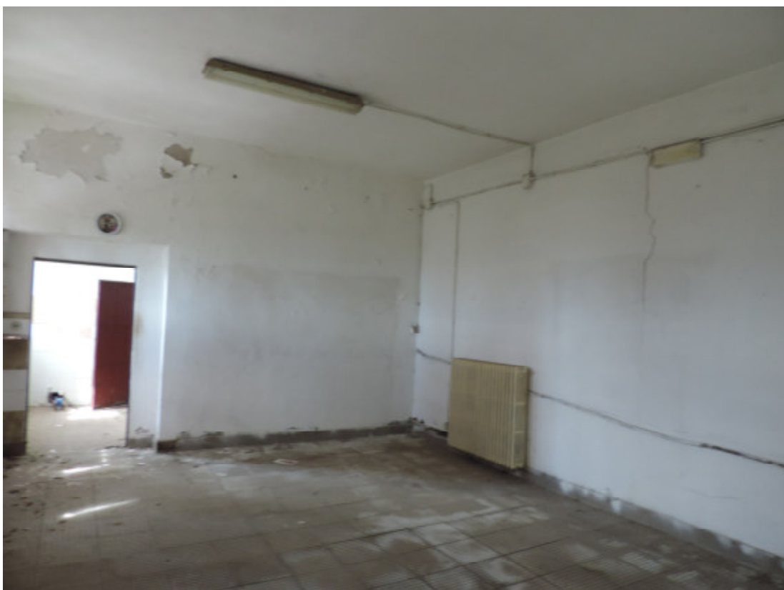
INTERNO PIANO TERRA
