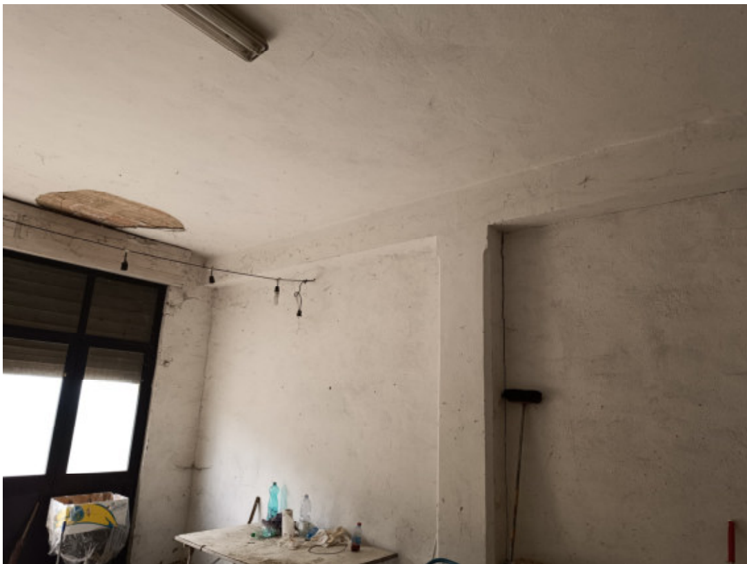
INTERNO PIANO TERRA
