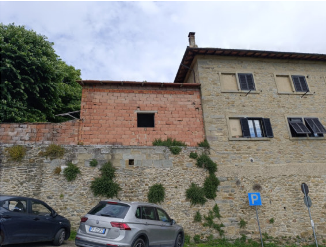
VISTA DA VIA DEL DUOMO VECCHIO
