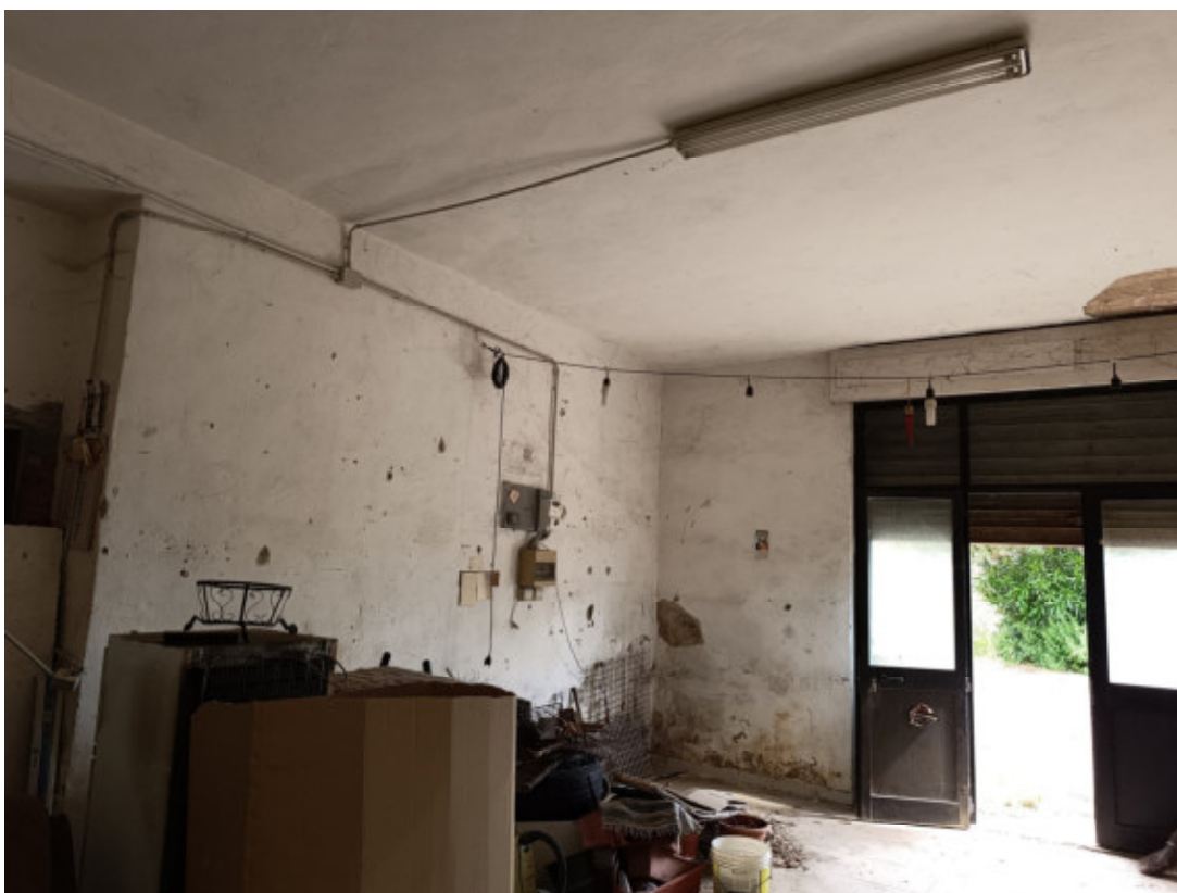
INTERNO PIANO TERRA
