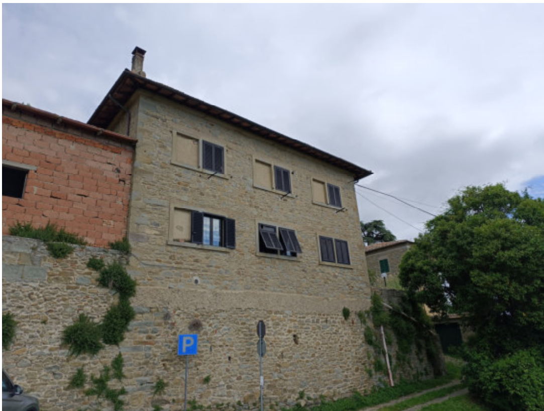
VISTA DA VIA DEL DUOMO VECCHIO
