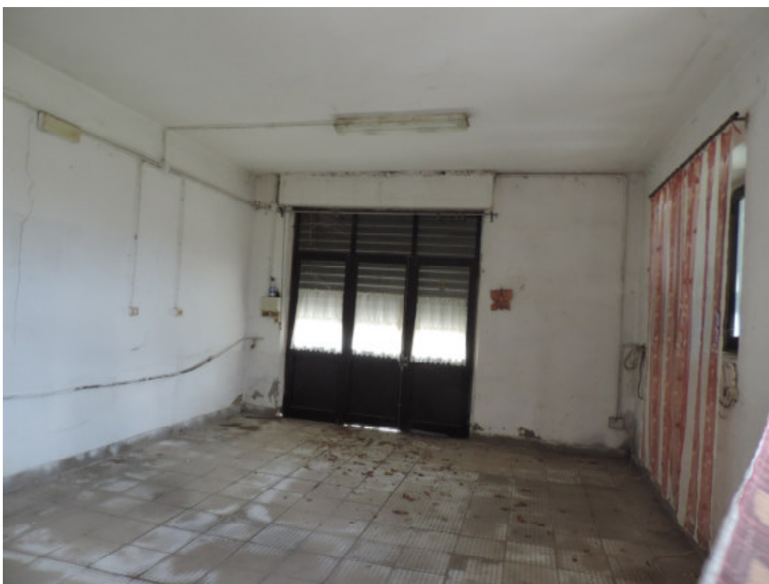
INTERNO PIANO TERRA
