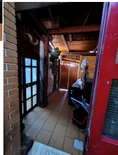
Foto n. 22: Particolare dell'accesso esterno alla zona cucina
