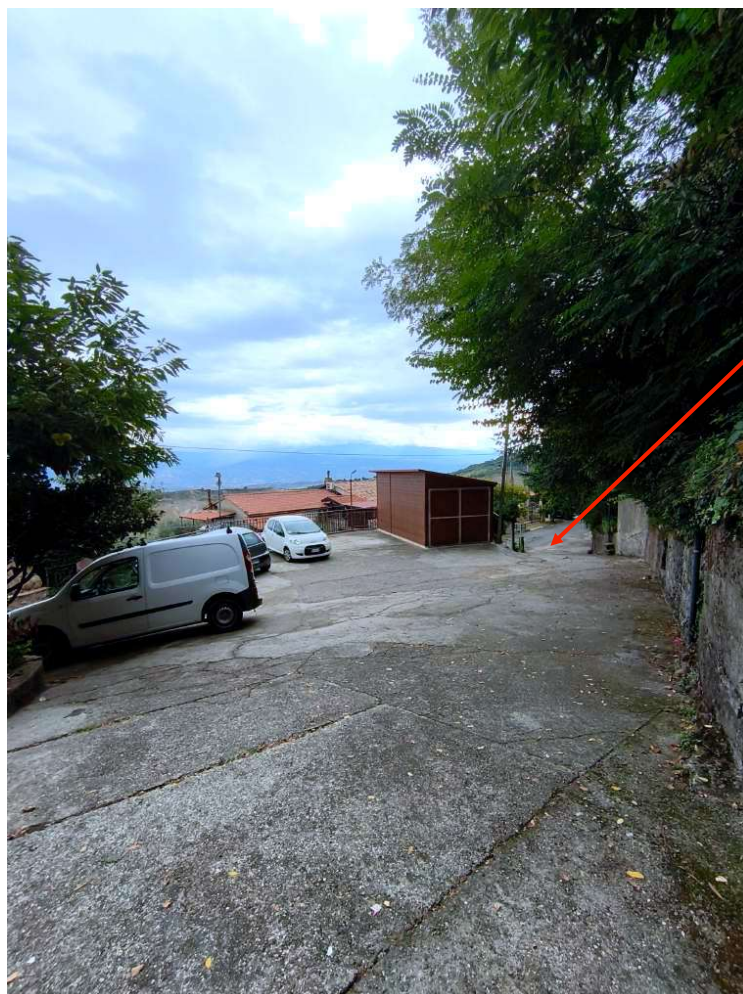
Foto n. 3: Accesso al fabbricato di cui fa parte l'immobile pignorato
