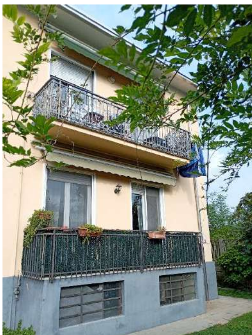
5) Particolare della facciata esterna (piano primo));
