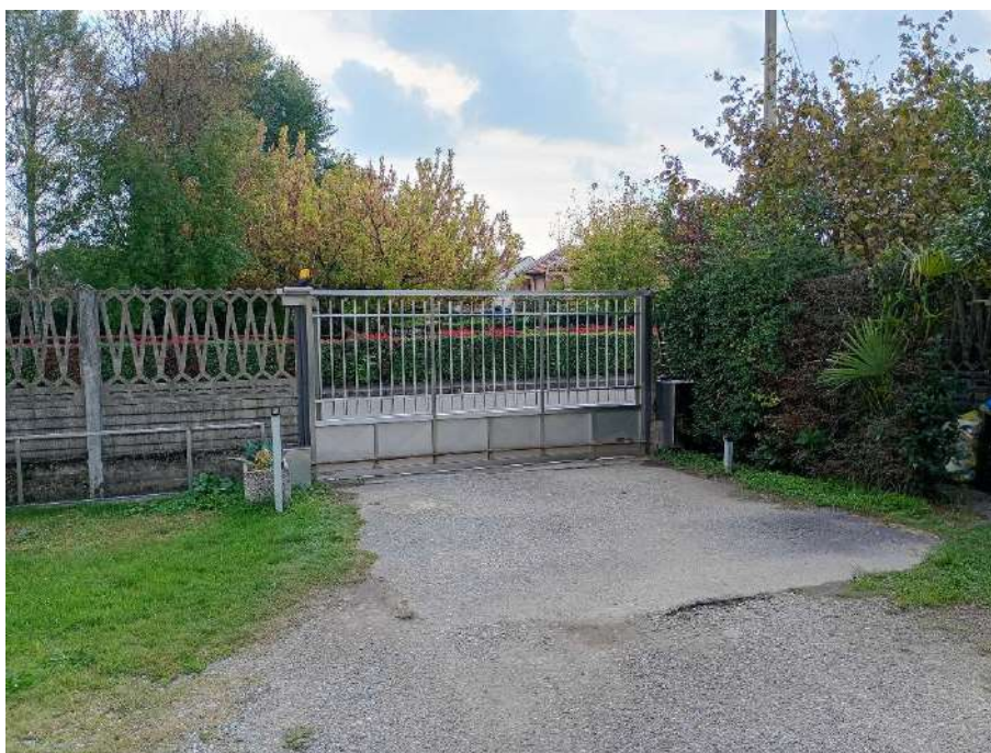
3) Vista da via Giovanni XXIII con particolare dell'accesso carraio;
