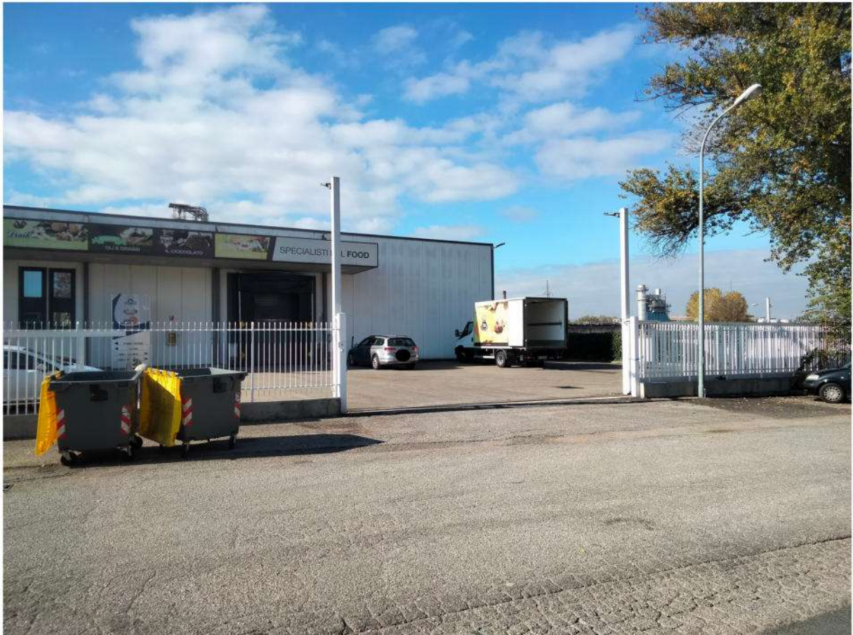
FOTO N. 2 - SECONDO ACCESSO CARRABILE
