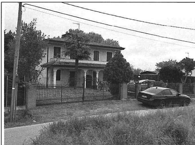
Foto n°4: Facciata principale dell'unità in esecuzione
