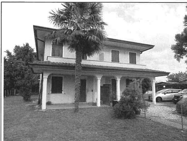
Foto n°6: Prospetto principale sud-ovest
