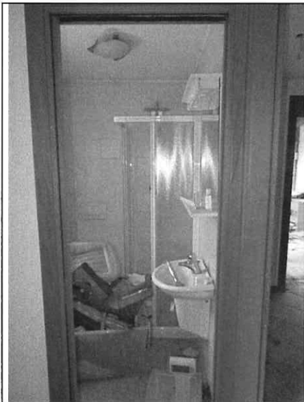
Foto n°14: Bagno al P.T.
