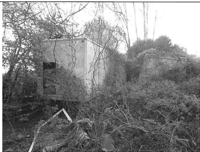
Foto n°56: Detriti e rottami ovunque
