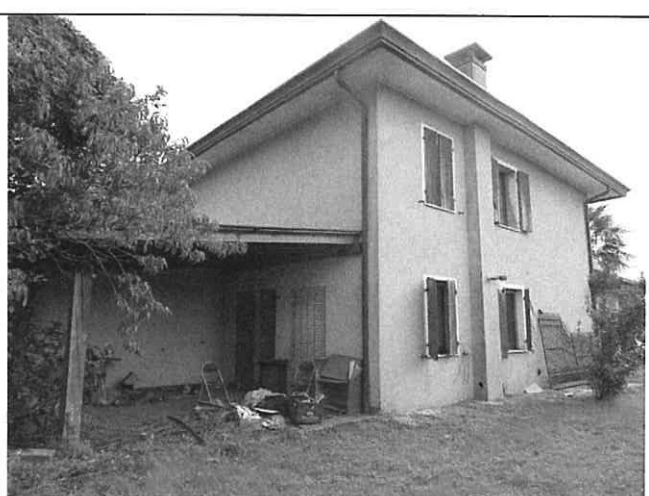
Foto n°9: Prospetto nord ovest
