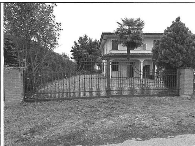
Foto n°5: Unità a sinistra
