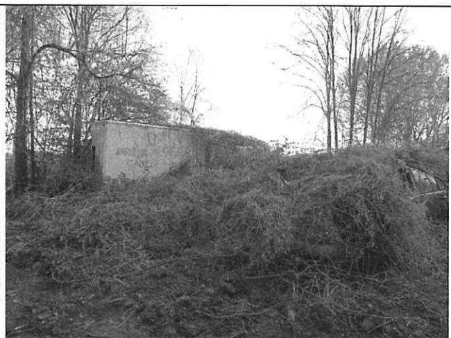
Foto n°46: Altra presenza di detriti e rottami
