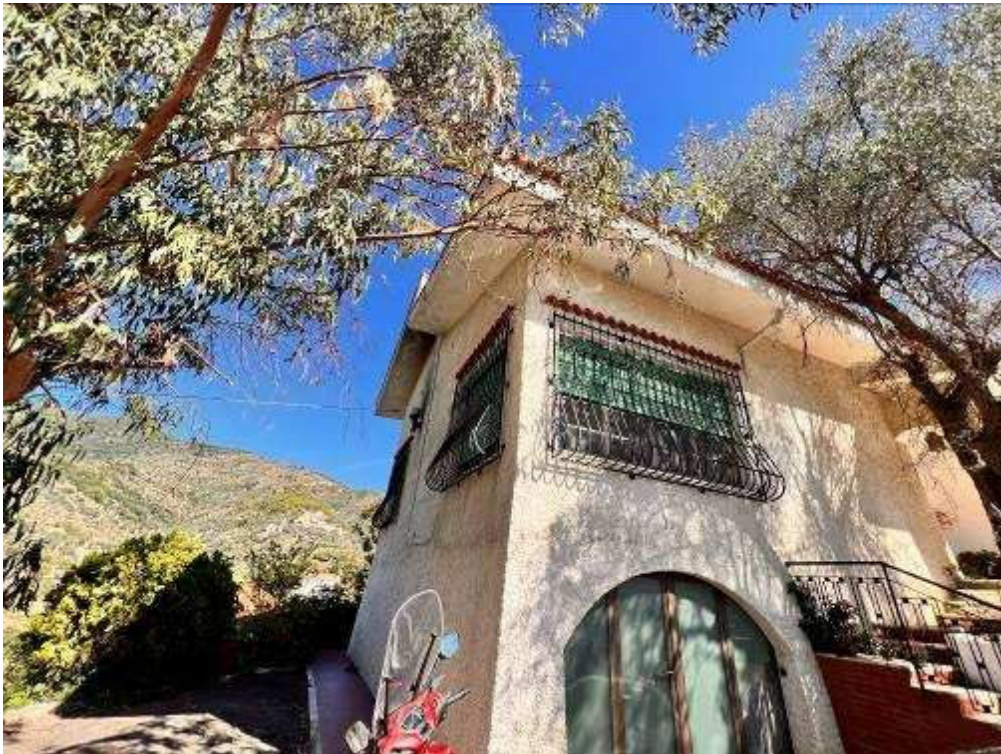
LOTTO 1 – CORPO B - Vista esterna
