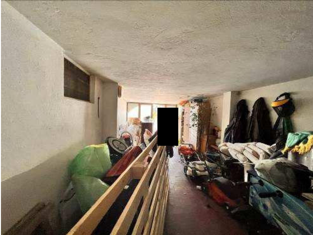
LOTTO 1 – CORPO A - Vista interna
