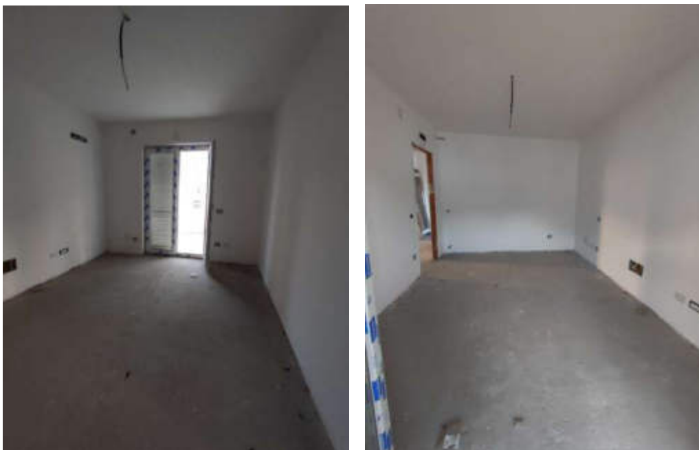
Fig. 67 e 68: Locale cucina appartamento lotto 8
