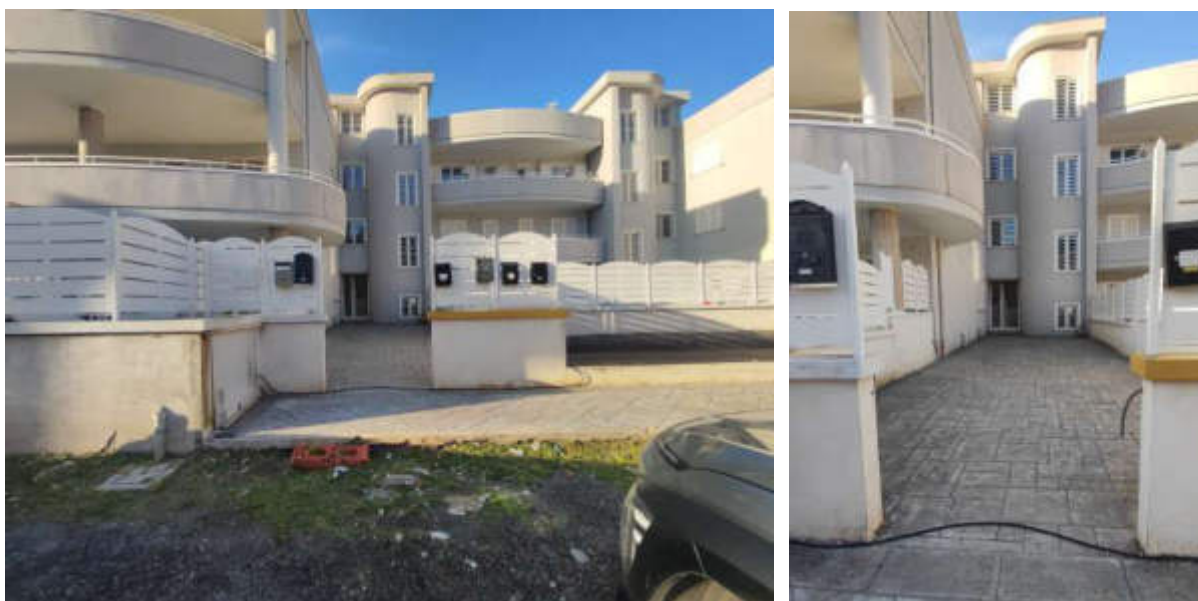
Fig. 51 e 52: Ingresso dell'edificio del compendio pignorato da via Giovanni XXIII
