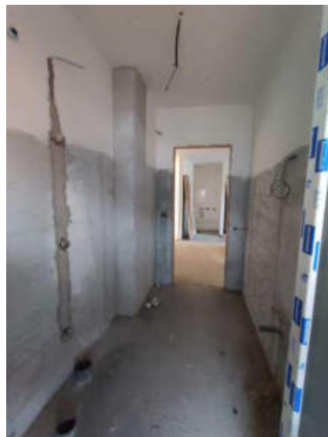
Fig. 70: Locale WC 2 appartamento lotto 8
