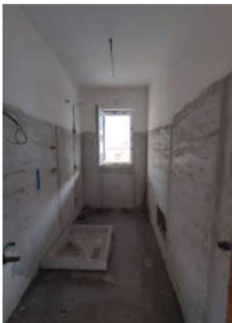
Fig. 69: Locale WC 1 appartamento lotto 8
