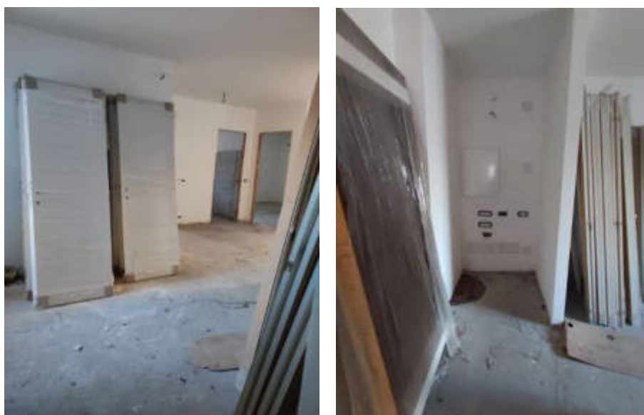
Fig. 59 e 60: Locale ingresso appartamento lotto 8
