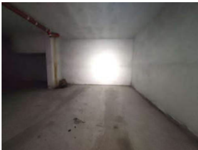
Fig. 28: Foto box sub 21 Lotto 3
