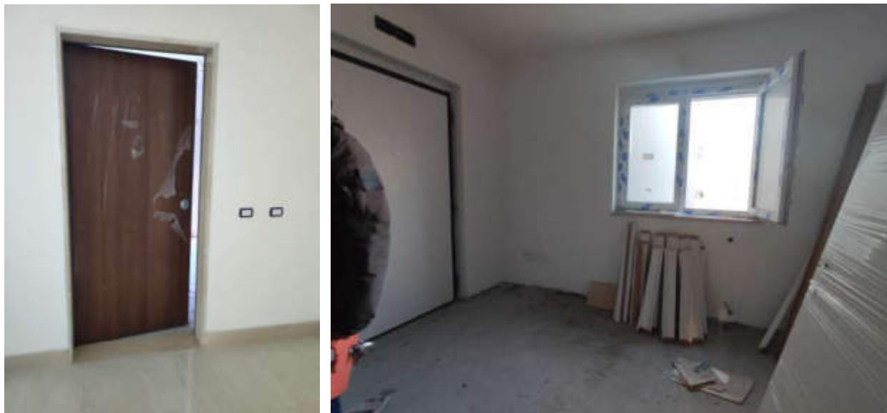
Fig. 57 e 58: Locale ingresso appartamento secondo piano lotto 8
