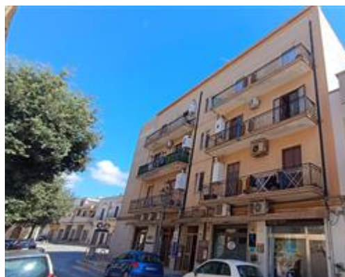
Vista dell'intero fabbricato da via Santa Margherita
