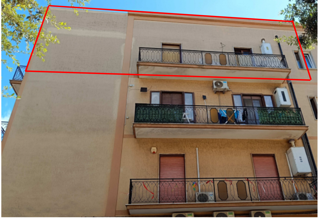
Vista appartamento da Via Santa Margherita
