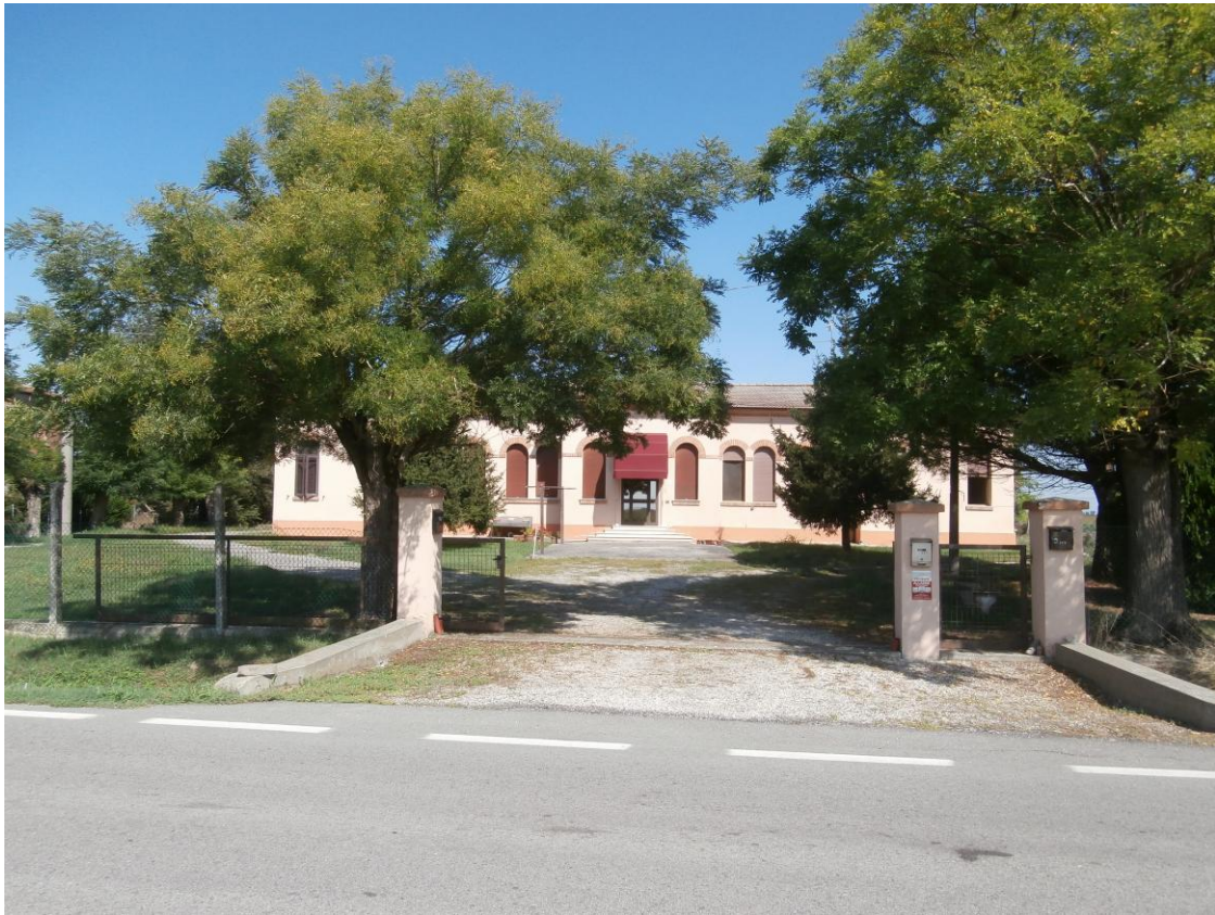
RIVA DEL PO' (FE), località Valgrande di Berra, via Pampano Brusantina n. 379
