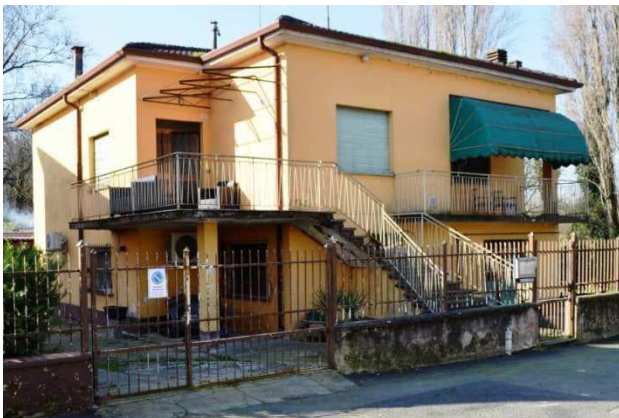
foto 3 - vista da nord-est su via Mons. Fontana della recinzione e del prospetto nord dell'edificio con la scala d'accesso esclusivo al terrazzo est a piano 1° con l'ingresso del LOTTO 2 e con l'accesso carraio dell'autorimessa (fuori campo a destra della foto) sotto il terrazzo con tenda verde
