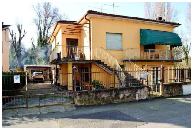
foto 2 - vista da nord su via Mons. Fontana dell'accesso del cancello d'accesso carrai del LOTTO 1 (in primo piano a sinistra della foto) sul tratto est della recinzione fronte strada del m.n. 873 CT. Sullo sfondo dietro al cancello si vede l'auto in stallo davanti al portone dell'autorimessa
