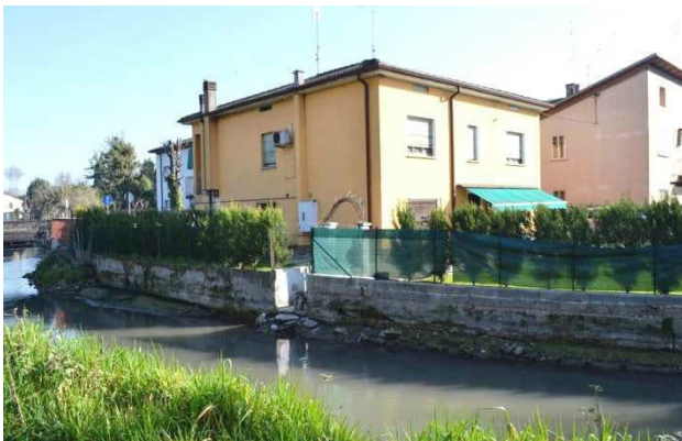
foto 3 - scorcio dei prospetti ovest e sud dell'edificio in via Mons. G. Fontana civ. 21/23 visti da sud ovest, con l'argine sinistro del fiume Piganzo (in primo piano nella foto) realizzato con muro verticale in c.c.a. con la recinzione ovest della pertinenza e scala d'accesso all'argine
