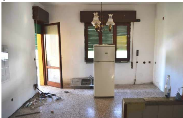
foto 2 - vista interna dalla cucina della zona pranzo e soggiorno dell'appartamento m.n. 873 sub 2 con lavori in corso d'integrale sostituzione dell'impianto elettrico per il riordino interno della unità: in secondo piano a sinistra della foto si vede la porta d'accesso al terrazzo ovest
