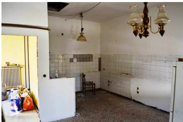
foto 4 - vista dalla zona soggiorno/pranzo a nord della zona cucina dell'appartamento m.n. 873 sub 2 a piano primo con lavori in corso per rifacimento completo dell'impianto elettrico in fase di predisposizione dei cavidotti sotto traccia
