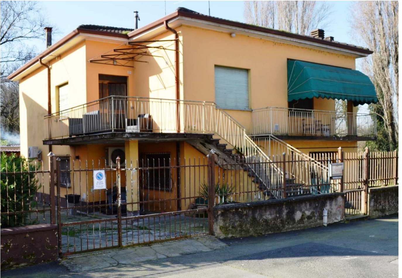
foto 4 - Vista del prospetto nord dell'appartamento a piano primo in via Mons. Fontana n. 23
