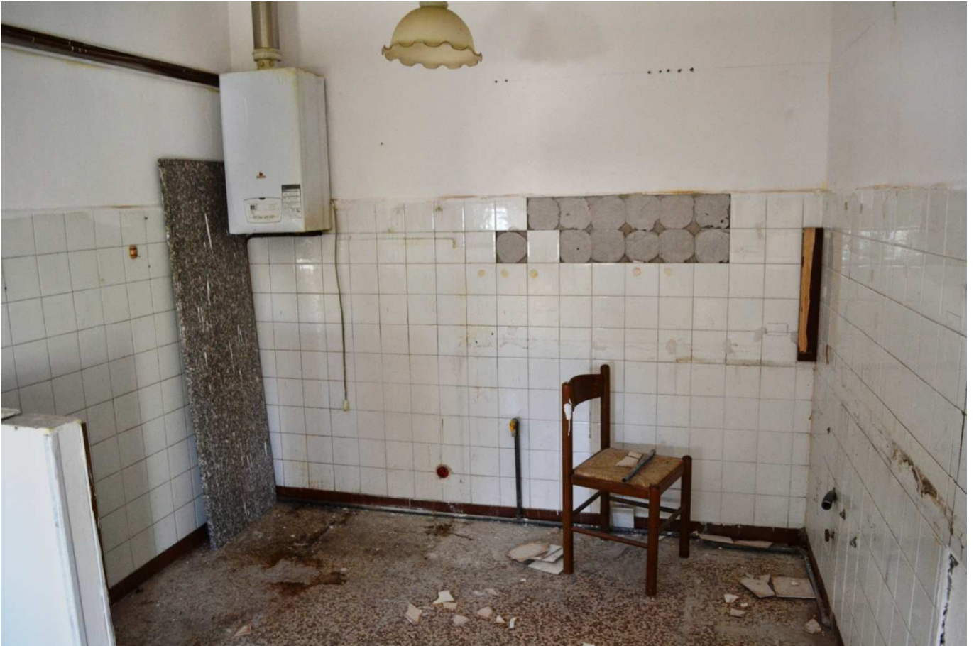
foto 9 - Appartamento a piano 1° in via Mons. Fontana, cucina - vista dal soggiorno, con lavori in corso
