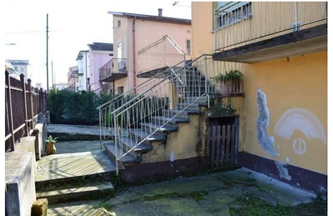
foto 6 - La scala d'ingresso a piano 1° vista da ovest
