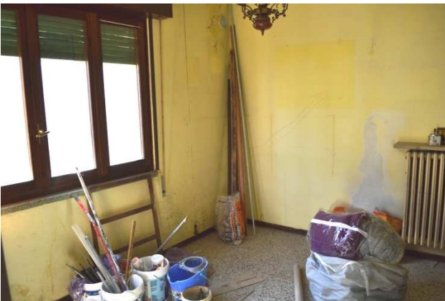
foto 10 - Vista dell'ingresso dell'appartamento
