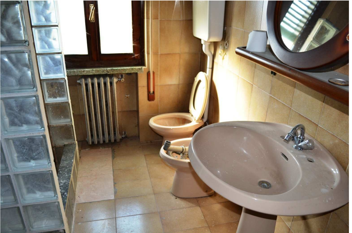
foto 14 - Appartamento a piano 1° in via Mons. Fontana, bagno - visto dall'ingresso, con lavori in corso
