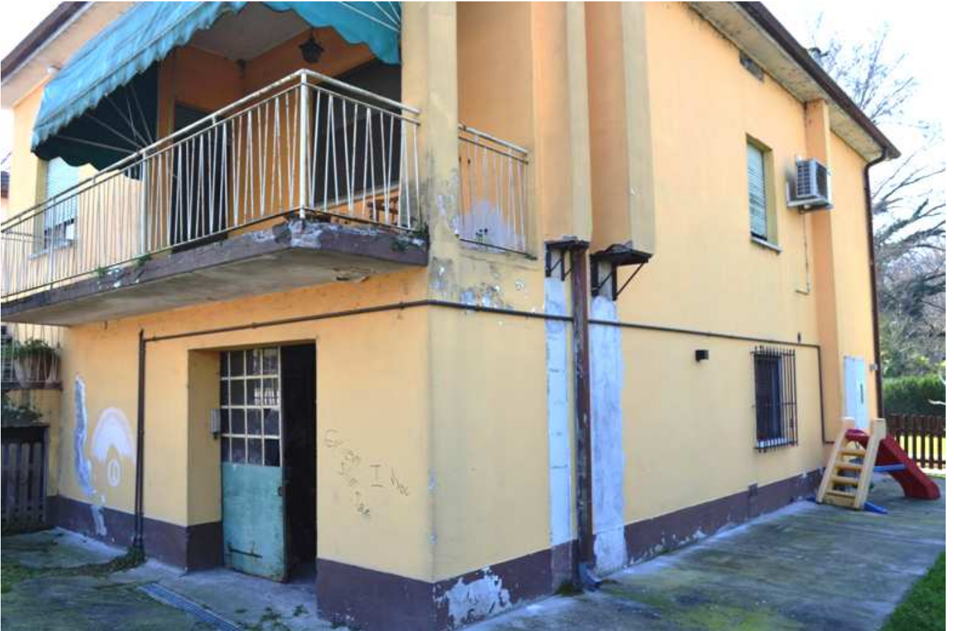
foto 19 - Appartamento a piano 1° in via Mons. Fontana, autorimessa - vista dell'ingresso a piano terra
