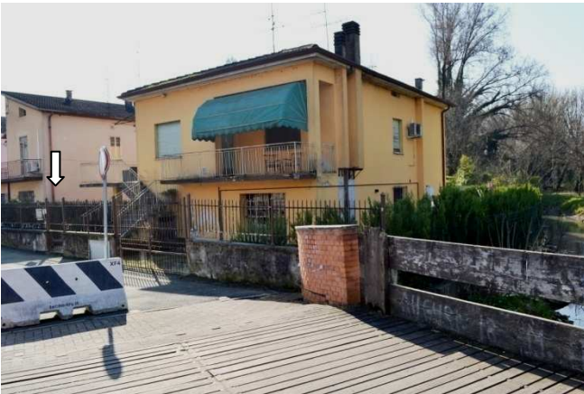
foto 5 - L'appartamento civ. 23 visto dal ponticello
