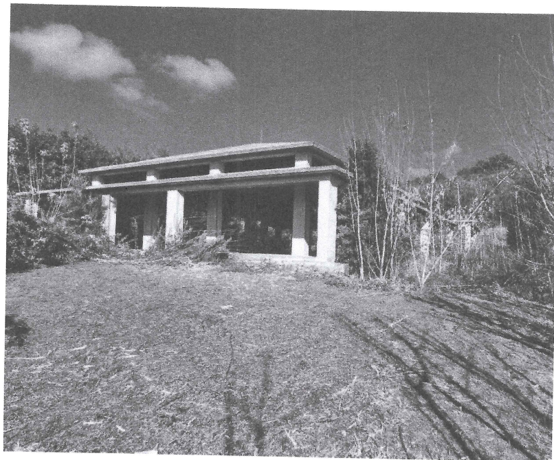
Foto 8. vista del fabbricato “Corpo 1”
