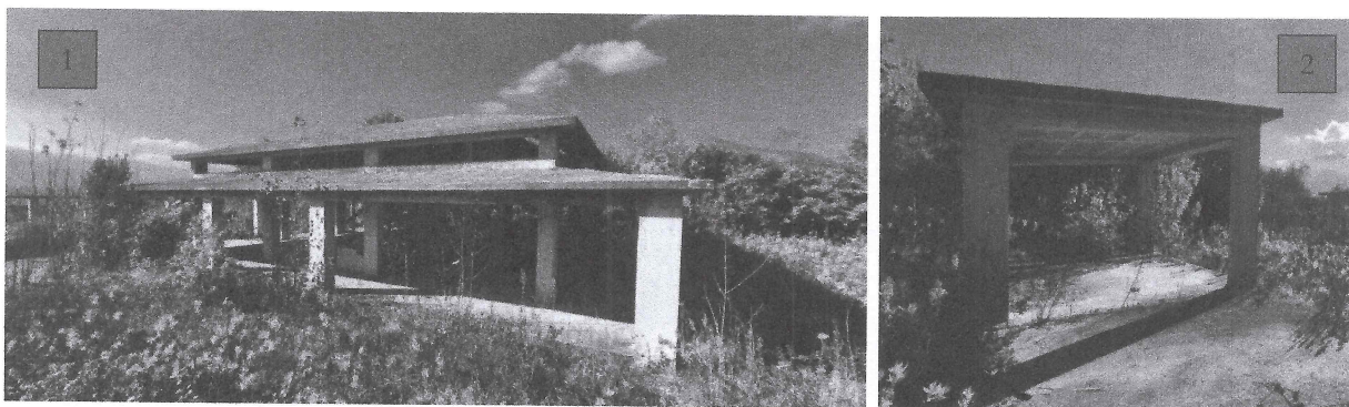
Foto 2 – 3. 1)Corpo di fabbrica principale 2) Corpo di fabbrica pertinenziale tettoia
