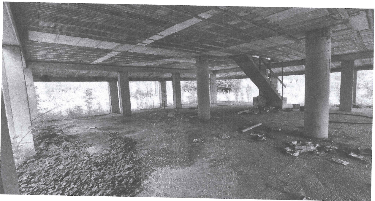
Foto 11. Vista del piano terra del fabbricato denominato "Corpo 1"
