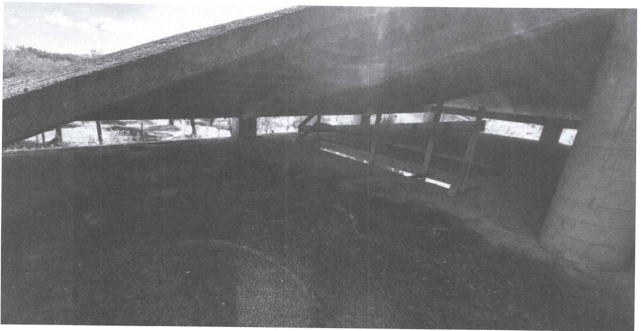
Foto 16. Vista del piano sottotetto del fabbricato denominato "Corpo 1"
