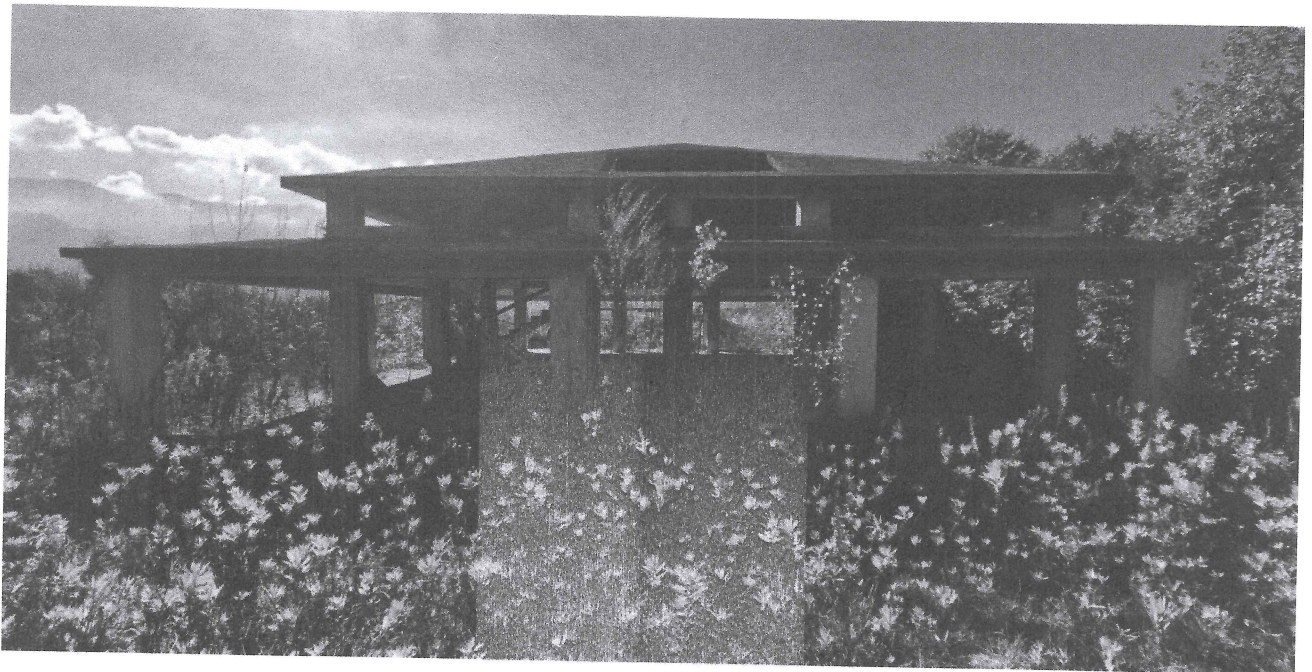
Foto 9. Vista prospetto nord del fabbricato "Corpo 1"
