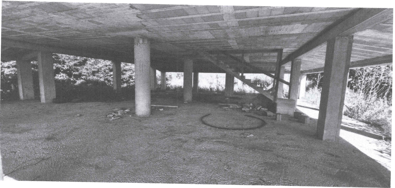
Foto 10. Vista del piano terra del fabbricato denominato "Corpo 1"
