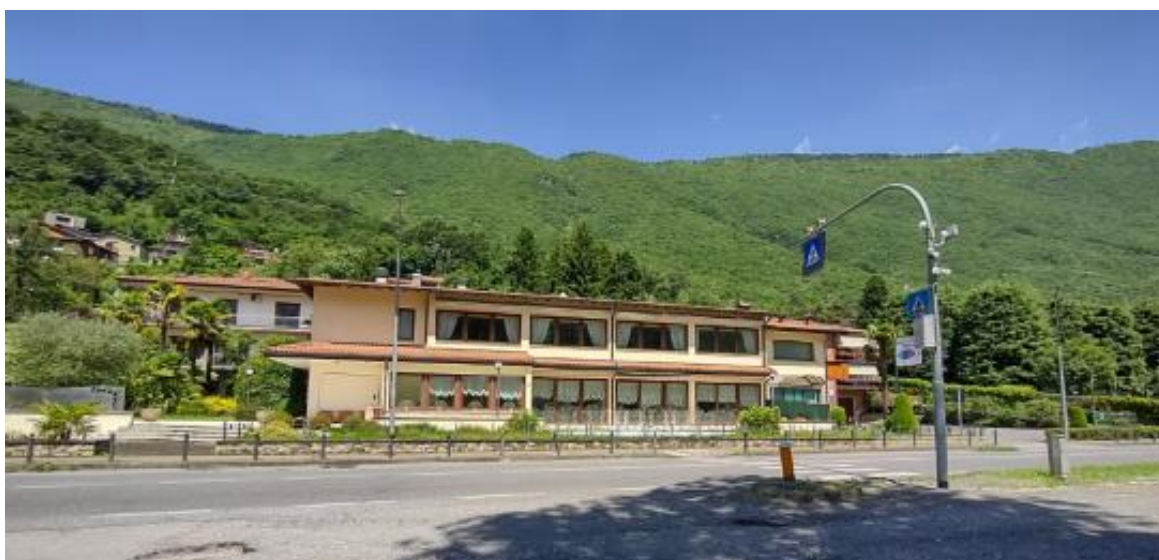
Vista del ristorante dalla strada statale SS42
