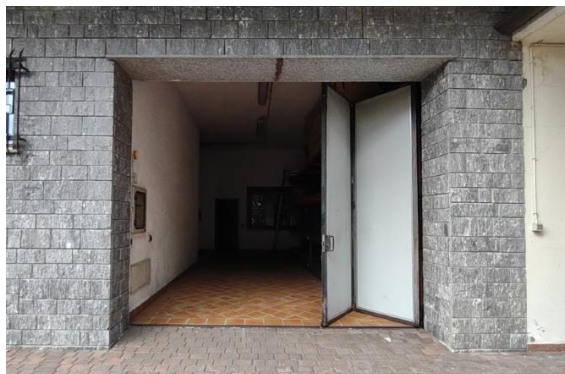
Portone di accesso locale deposito
