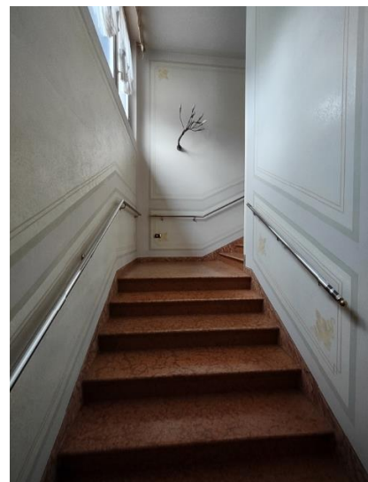
Scala al piano primo – prima rampa
