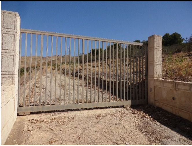
Foto 4-Cancello di accesso (in adiacenza alla SP64)
