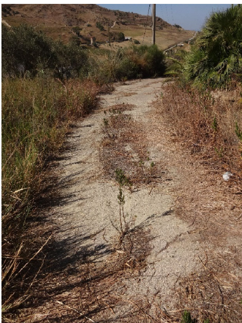
Foto 14-Viabilità interna al terreno (dissestata)
