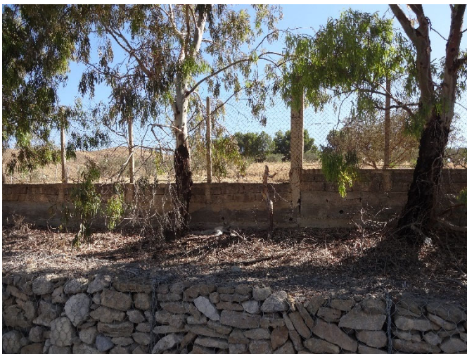
Foto 9-Recinzione lato sud (in adiacenza alla SP64)
