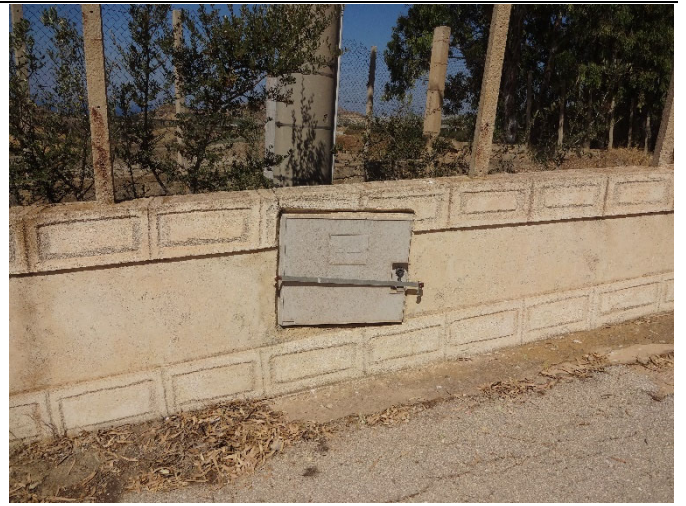
Foto 5-Particolare del muretto adiacente il cancello di accesso
