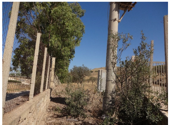
Foto 8-Recinzione (in prossimità del cancello di accesso)
