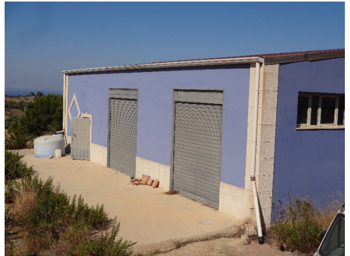
Foto 24-Particolare del prospetto principale
