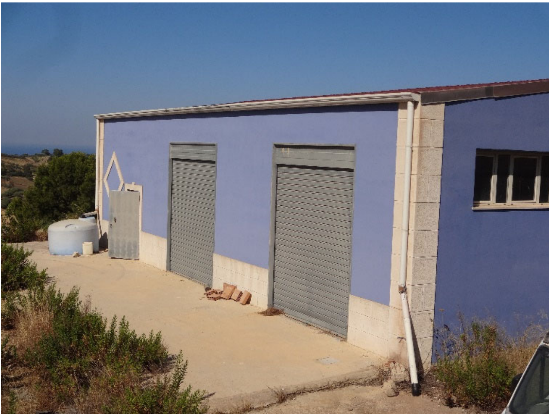
Foto 25-Particolare del prospetto principale
