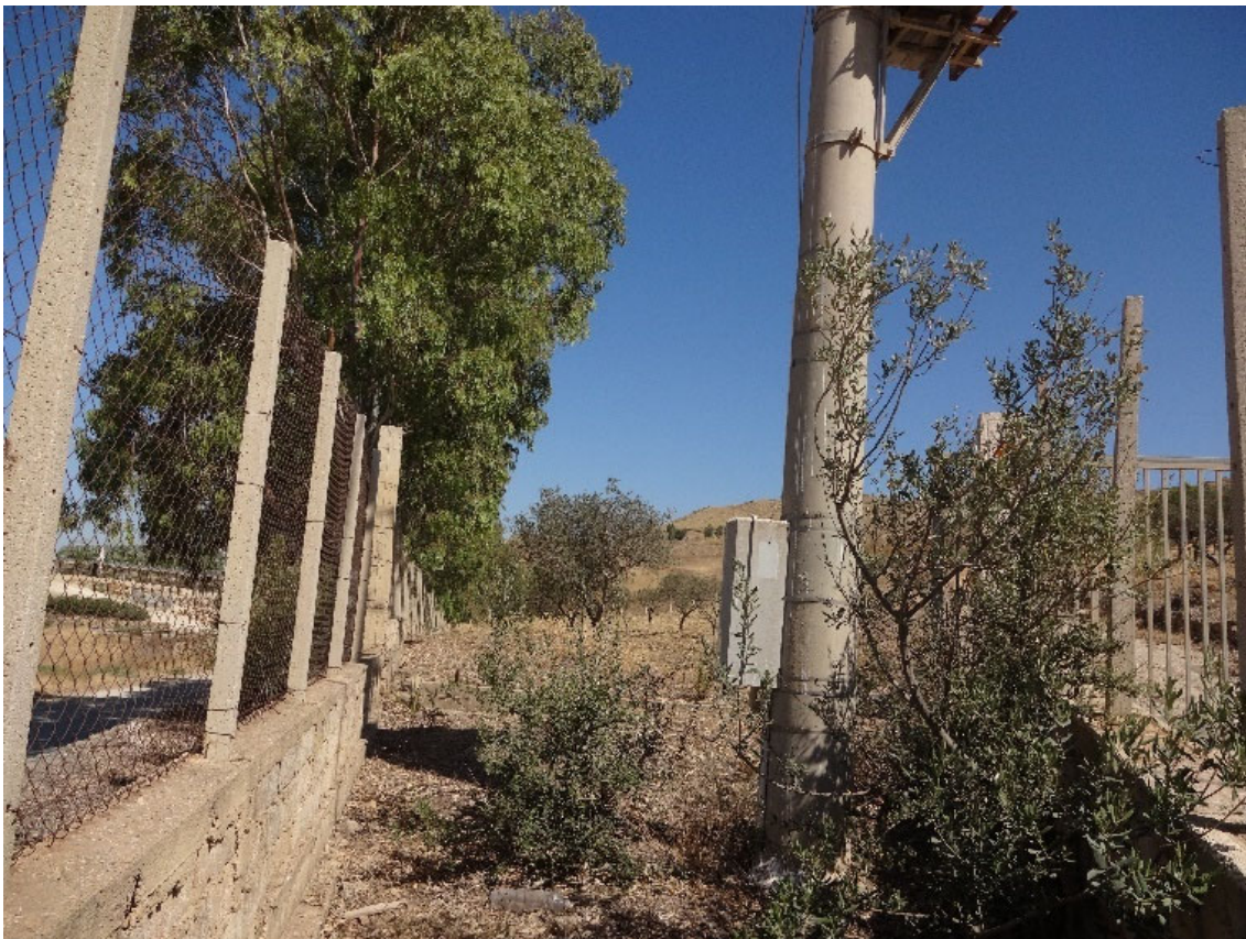
Foto 9-Recinzione (in prossimità del cancello di accesso)
