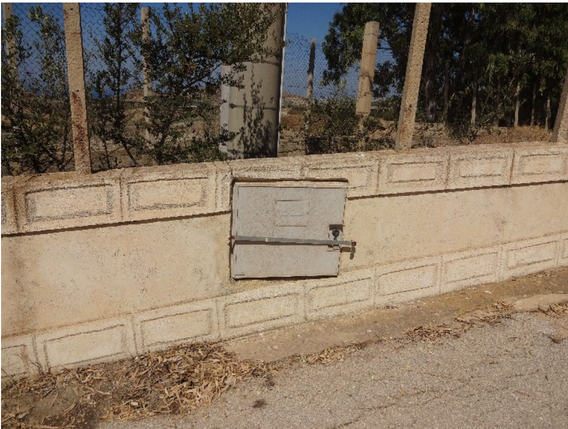
Foto 5-Particolare del muretto adiacente il cancello di accesso
