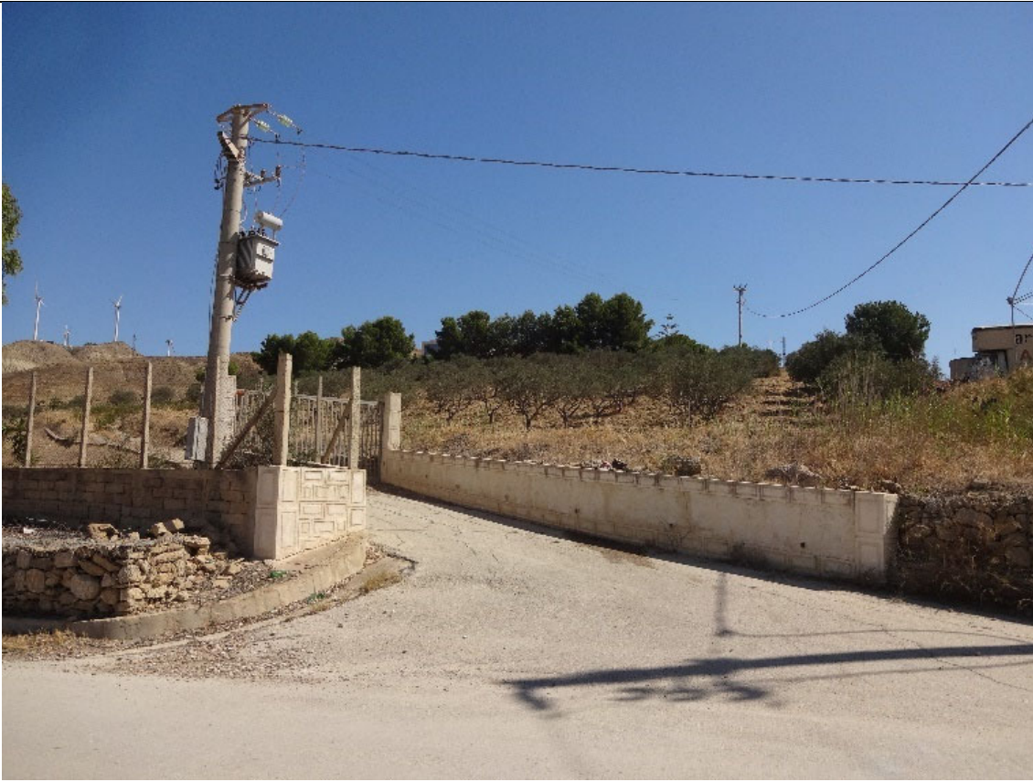
Foto 2-Cancello di accesso (in adiacenza alla SP64)
