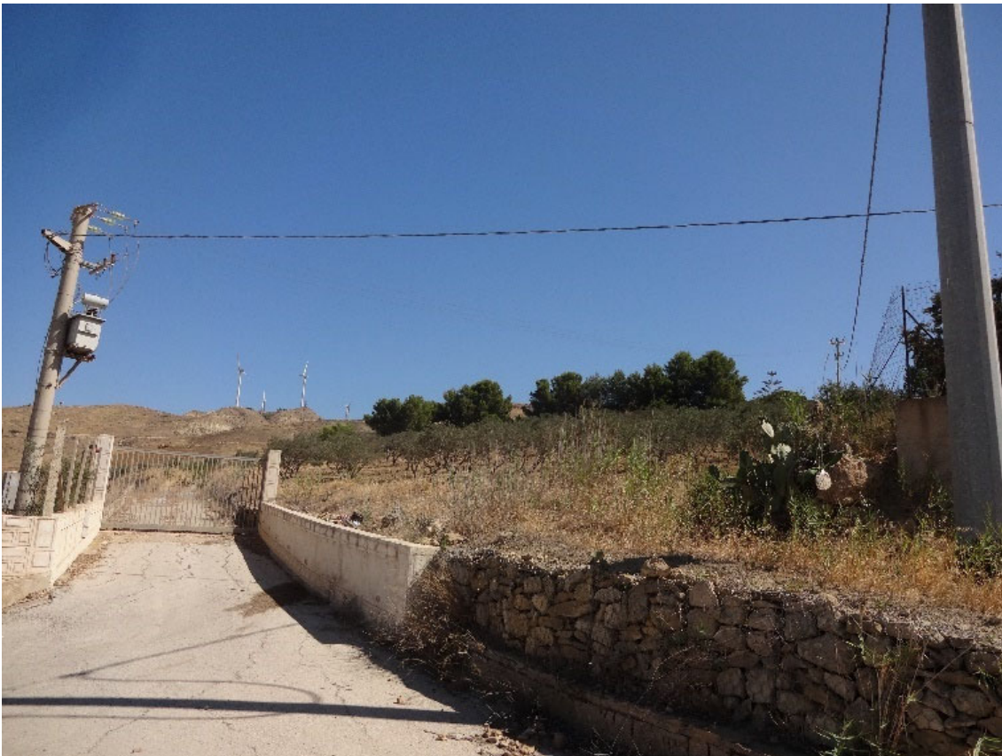
Foto 3-Cancello di accesso (in adiacenza alla SP64)
