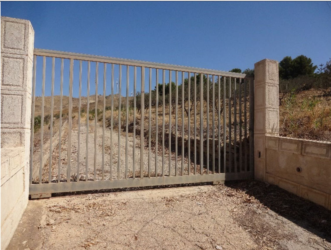
Foto 4-Cancello di accesso (in adiacenza alla SP64)
