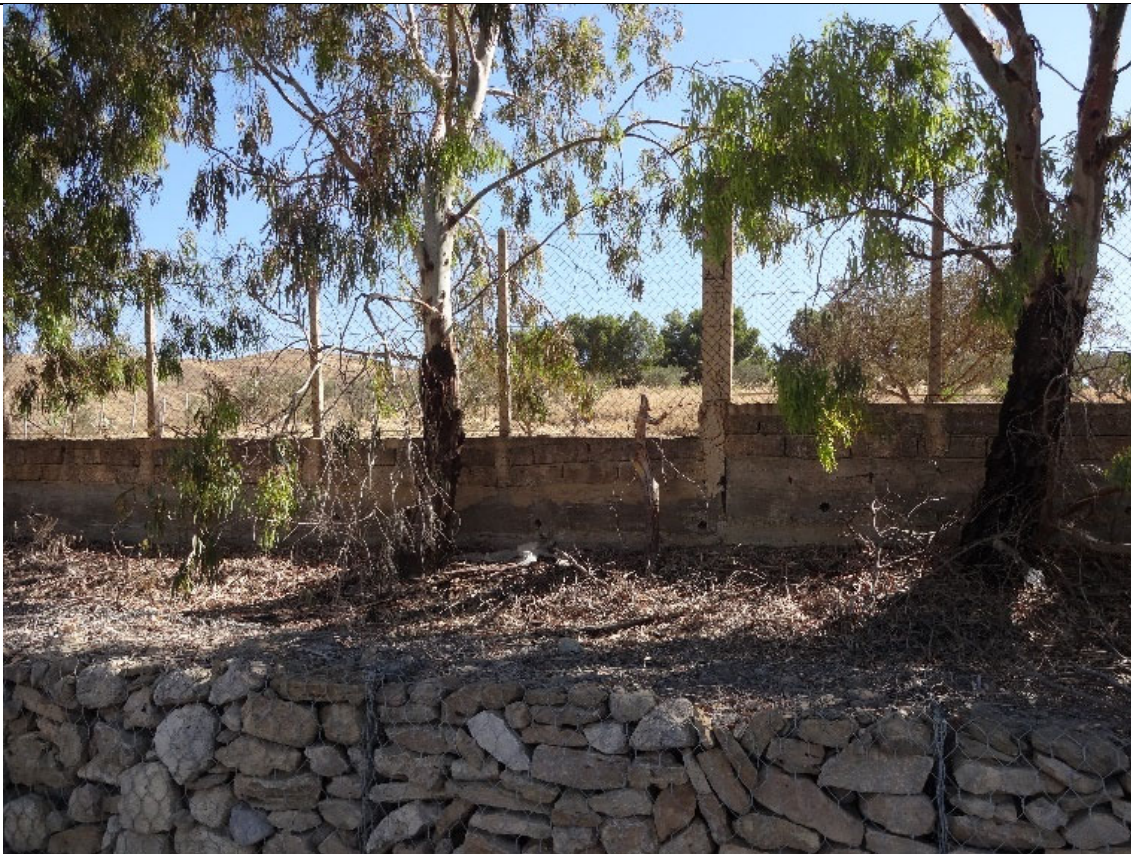
Foto 8-Recinzione lato sud (in adiacenza alla SP64)
